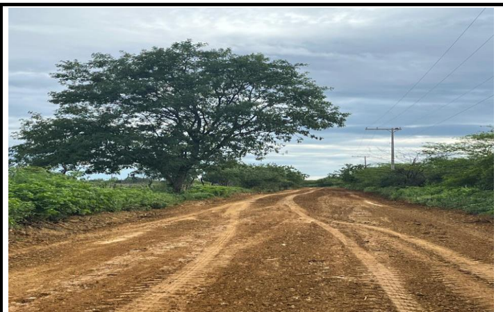
FOTO 07 - EXECUÇÃO DE SERVIÇOS DE ADEQUAÇÃO DE ESTRADAS VICINAIS NO MUNICÍPIO DE ITAGUAÇU/BA
