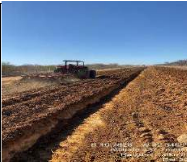
EXECUÇÃO DE SUB LEITO
