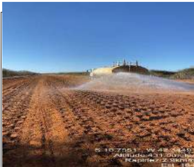
EXECUÇÃO DE ATERRO
