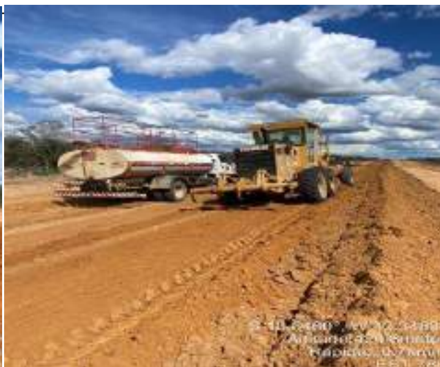
EXECUÇÃO DE SUB LEITO
