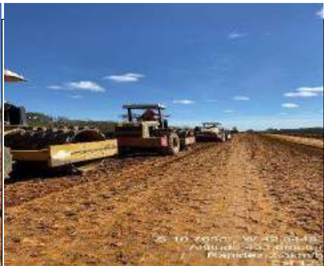
EXECUÇÃO DE ATERRO
