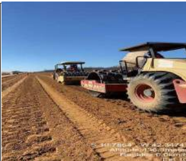
EXECUÇÃO DE SUB LEITO
