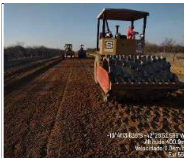
EXECUÇÃO DE SUB BASE
