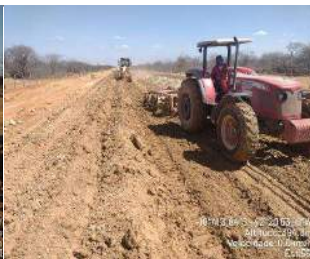
EXECUÇÃO DE SUB BASE
