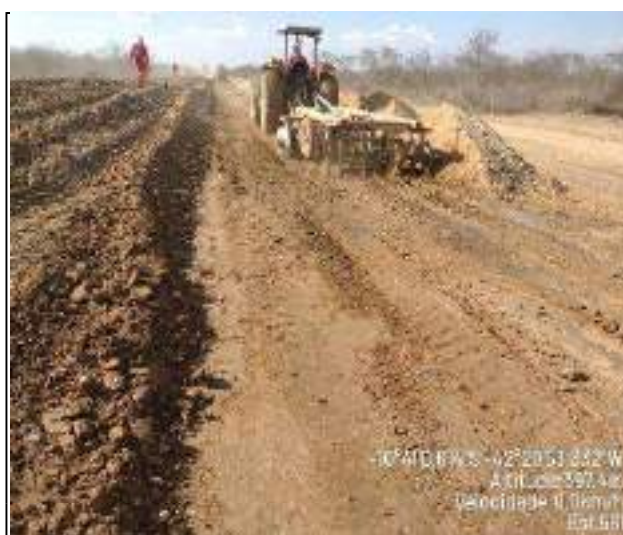
EXECUÇÃO DE SUB BASE
