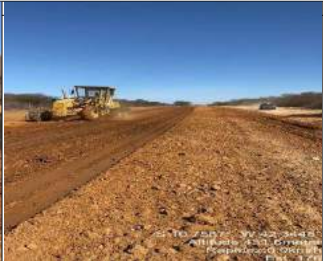
EXECUÇÃO DE ATERRO
