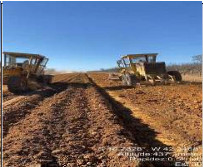
EXECUÇÃO DE SUB LEITO
