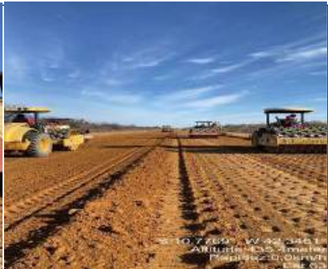
EXECUÇÃO DE SUB LEITO
