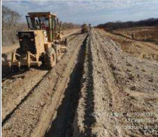
EXECUÇÃO DE SUB BASE
