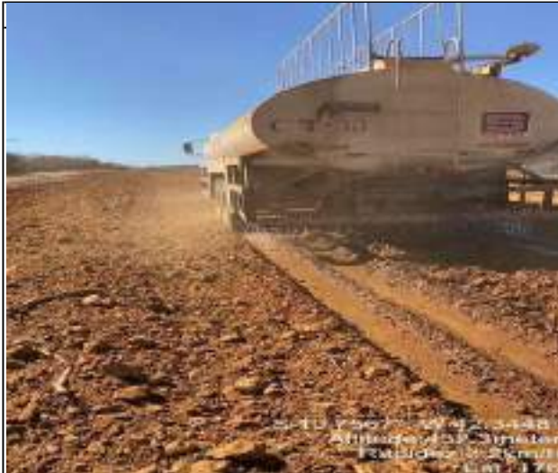
EXECUÇÃO DE ATERRO
