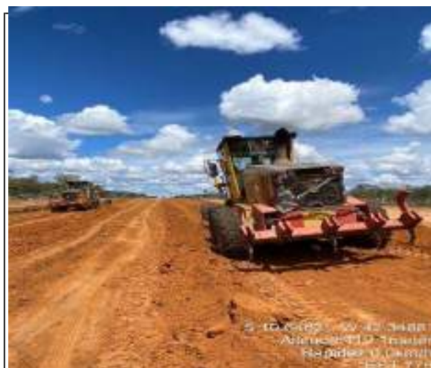
EXECUÇÃO DE SUB LEITO
