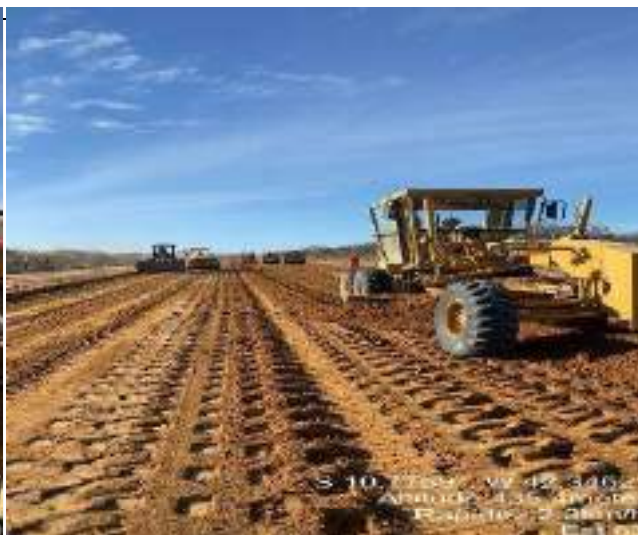
EXECUÇÃO DE SUB LEITO
