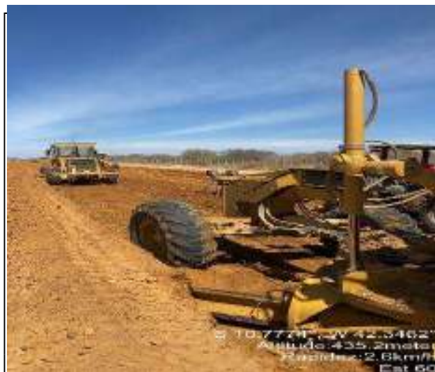
EXECUÇÃO DE SUB LEITO
