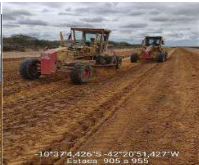
EXECUÇÃO DE ATERRO
