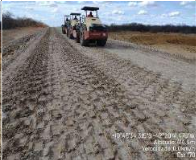
EXECUÇÃO DE SUB BASE
