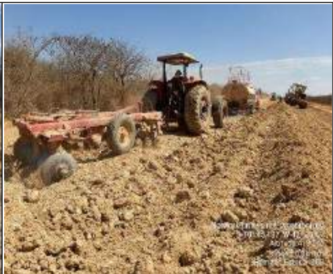
EXECUÇÃO DE SUB BASE
