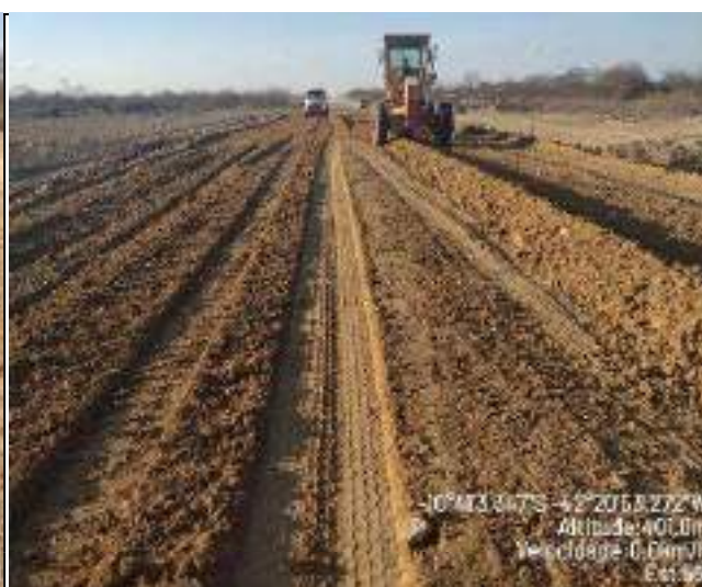
EXECUÇÃO DE SUB BASE
