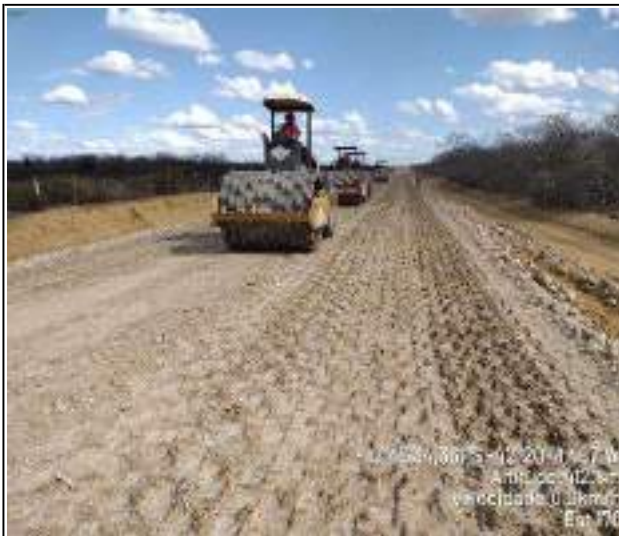
EXECUÇÃO DE SUB BASE
