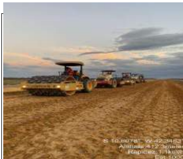
EXECUÇÃO DE ATERRO
