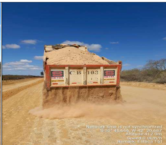
LANÇAMENTO DE SUB-BASE
