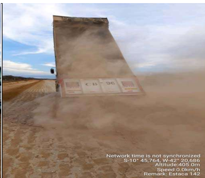
LANÇAMENTO DE SUB-BASE
