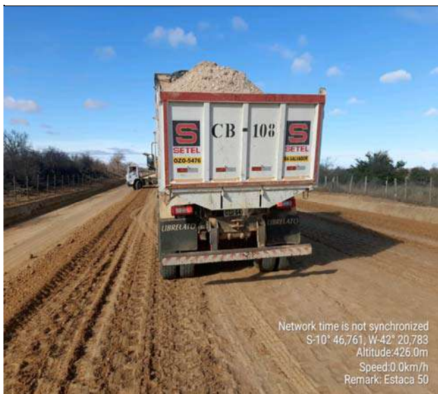
LANÇAMENTO DE SUB-BASE
