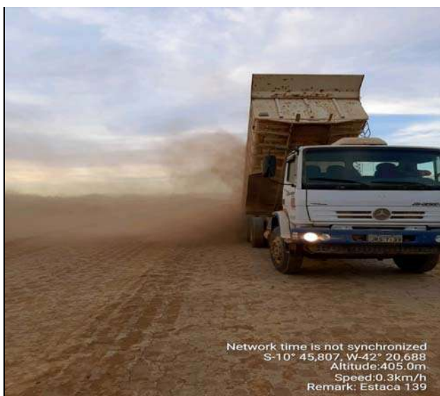
LANÇAMENTO DE SUB-BASE
