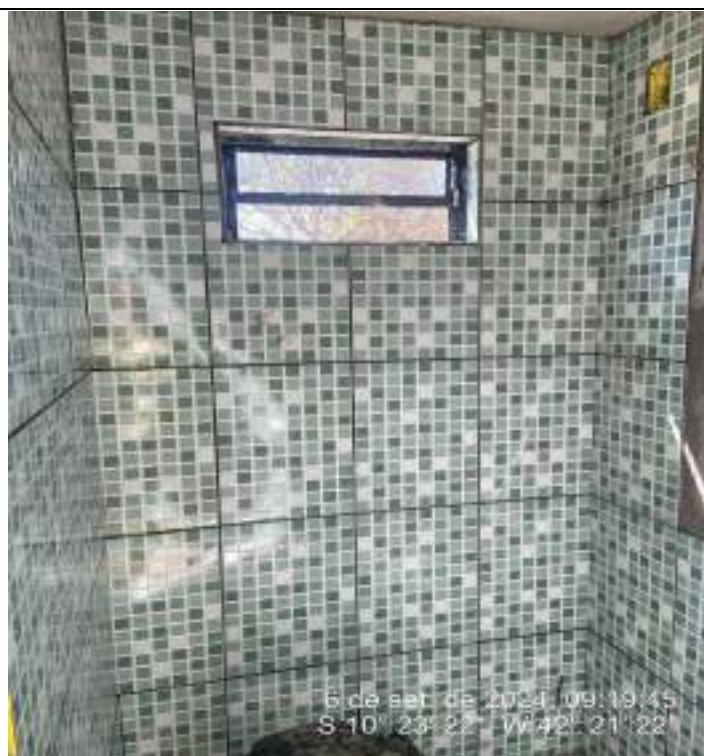
MELHORIAS SANITÁRIAS DOMICIAIS NO MUNICÍPIO DE ITAGUAÇU DA BAHIA-BA.
