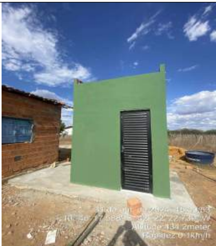
MELHORIAS SANITÁRIAS DOMICIAIS NO MUNICÍPIO DE ITAGUAÇU DA BAHIA-BA.
