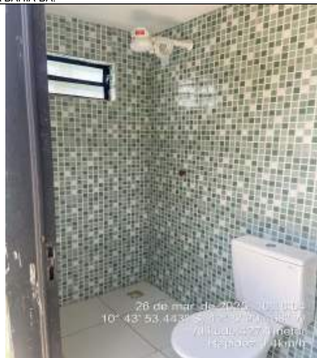
MELHORIAS SANITÁRIAS DOMICIAIS NO MUNICÍPIO DE ITAGUAÇU DA BAHIA-BA.
