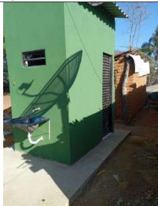
MELHORIAS SANITÁRIAS DOMICIAIS NO MUNICÍPIO DE ITAGUAÇU DA BAHIA-BA.
