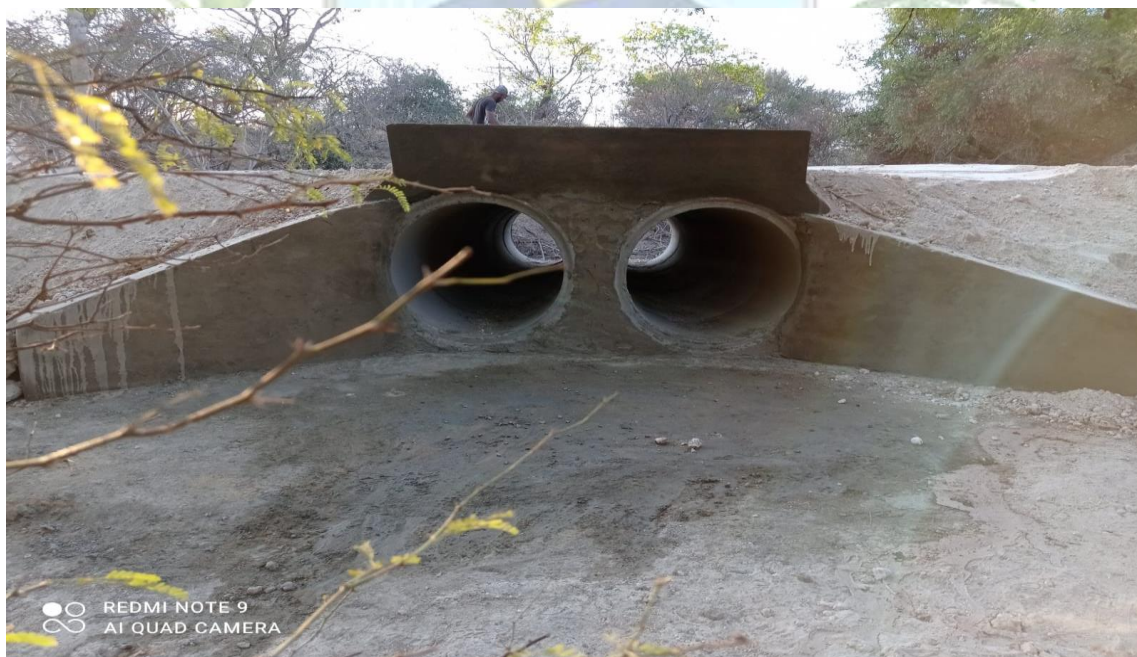
FOTO 04: Bueiro Duplo Tubular de Concreto (Execução Empresa Arruda Engenharia LTDA).
