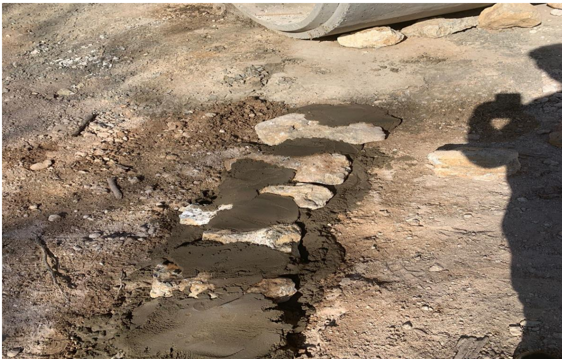
FOTO 03: Bueiro Duplo Tubular de Concreto (Execução Empresa Arruda Engenharia LTDA)
