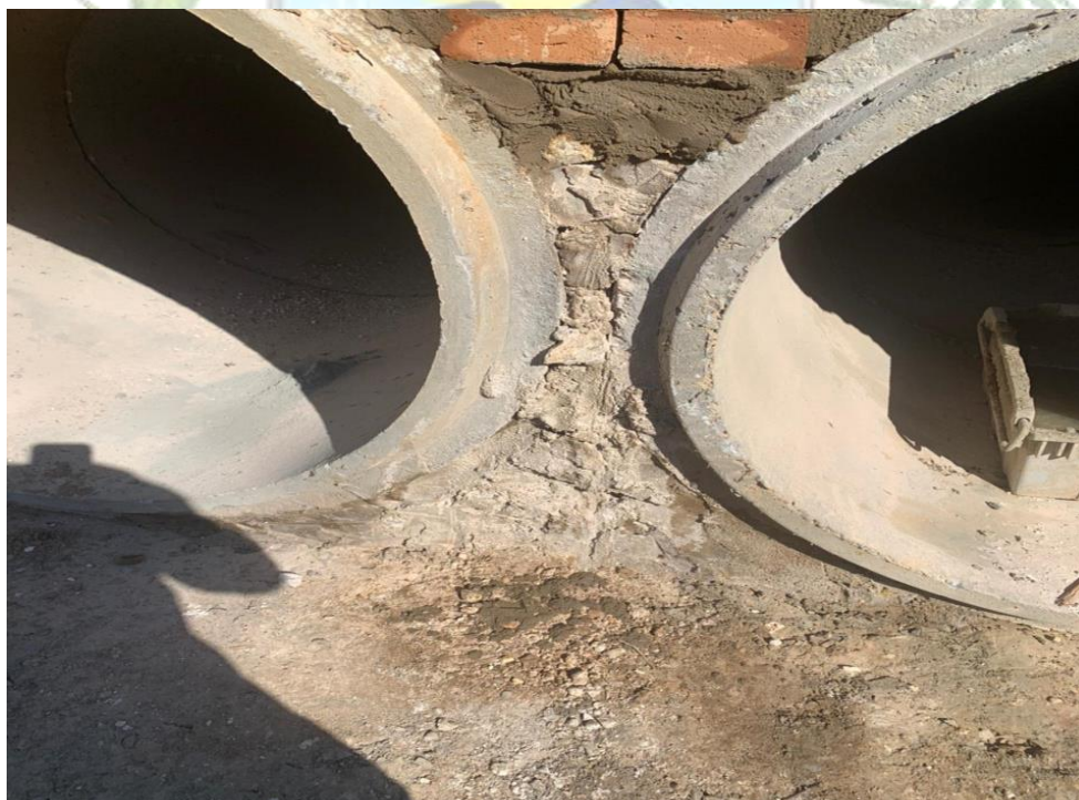
FOTO 02: Bueiro Duplo Tubular de Concreto (Execução Empresa Arruda Engenharia LTDA).
