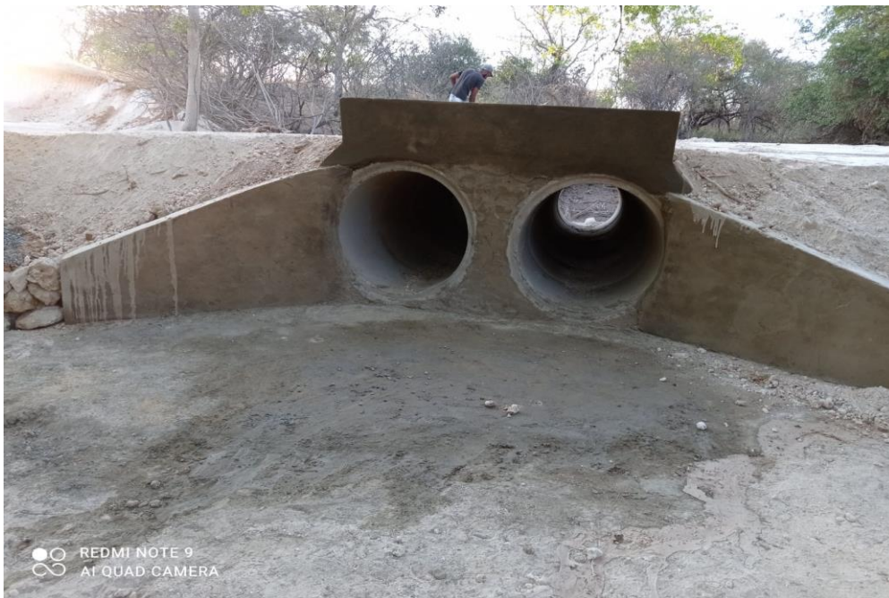
FOTO 01: Bueiro Duplo Tubular de Concreto (Execução Empresa Arruda Engenharia LTDA).
