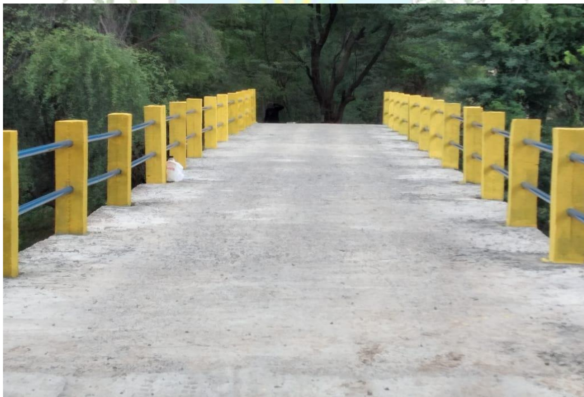
FOTO 06: Recuperação de ponte sobre rio, trecho indicado em projeto (Execução Empresa Arruda Engenharia LTDA).
