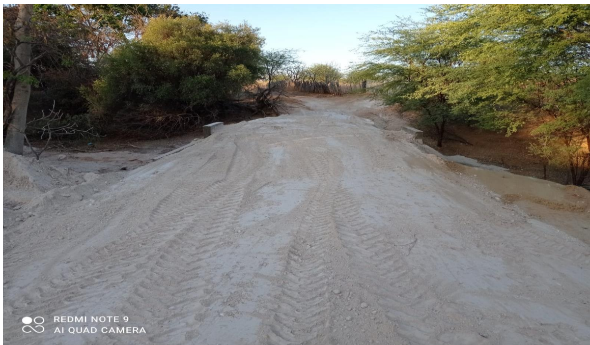
FOTO 05: Bueiro Duplo Tubular de Concreto (Execução Empresa Arruda Engenharia LTDA).
