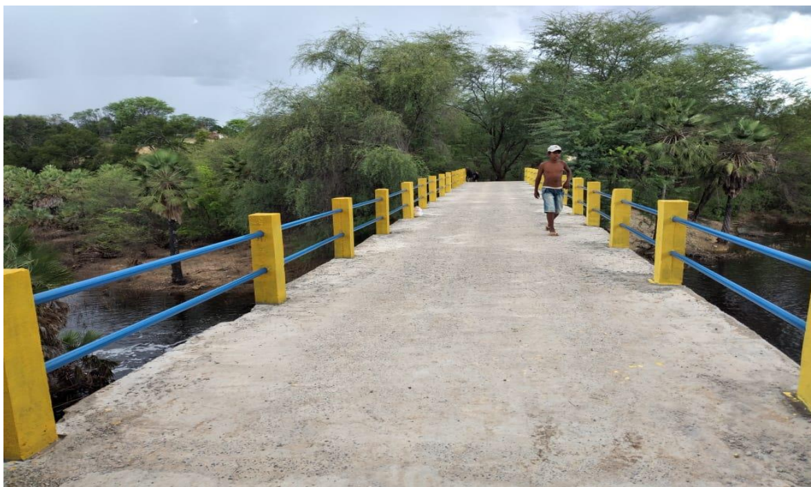
FOTO 07: Recuperação de ponte sobre rio, trecho indicado em projeto (Execução Empresa Arruda Engenharia LTDA).
