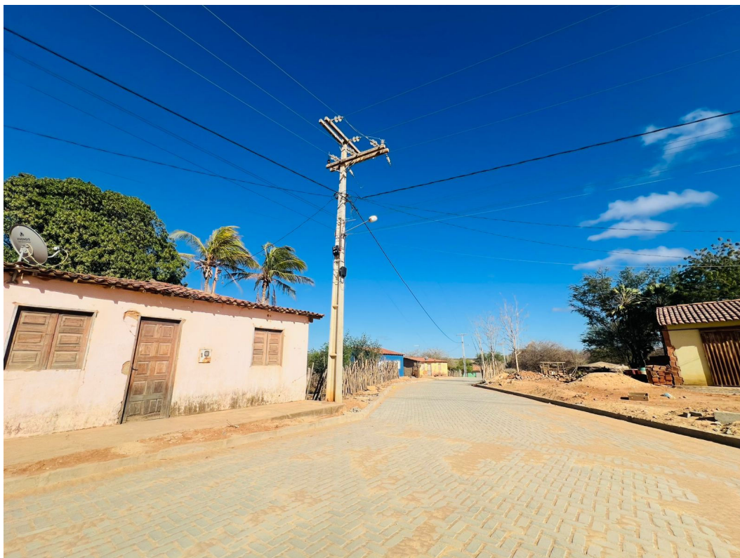
IMAGEM 11: PAVIMENTAÇÃO NO POVOADO DE TABATINGA ITAGUAÇU DA BAHIA - BAHIA
