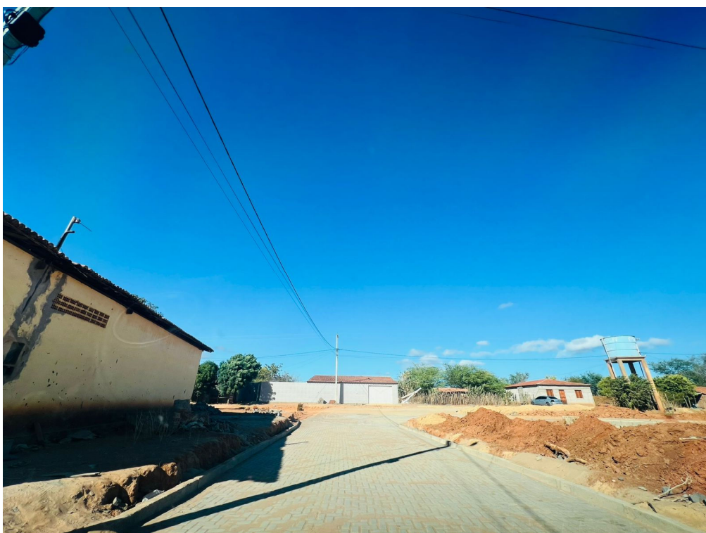
IMAGEM 05: PAVIMENTAÇÃO NO POVOADO DE TABATINGA ITAGUAÇU DA BAHIA - BAHIA
