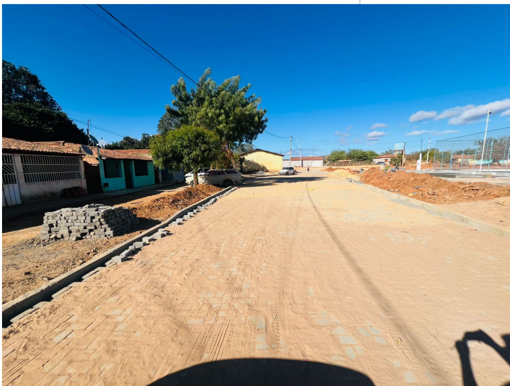
IMAGEM 04: PAVIMENTAÇÃO NO POVOADO DE TABATINGA ITAGUAÇU DA BAHIA - BAHIA
