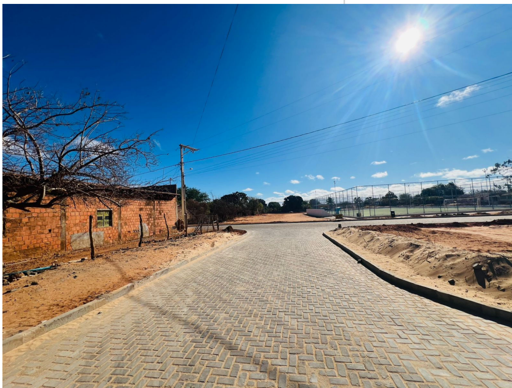
IMAGEM 08: PAVIMENTAÇÃO NO POVOADO DE TABATINGA ITAGUAÇU DA BAHIA - BAHIA
