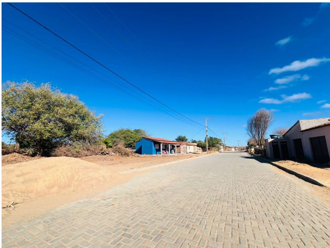
IMAGEM 09: PAVIMENTAÇÃO NO POVOADO DE TABATINGA ITAGUAÇU DA BAHIA - BAHIA
