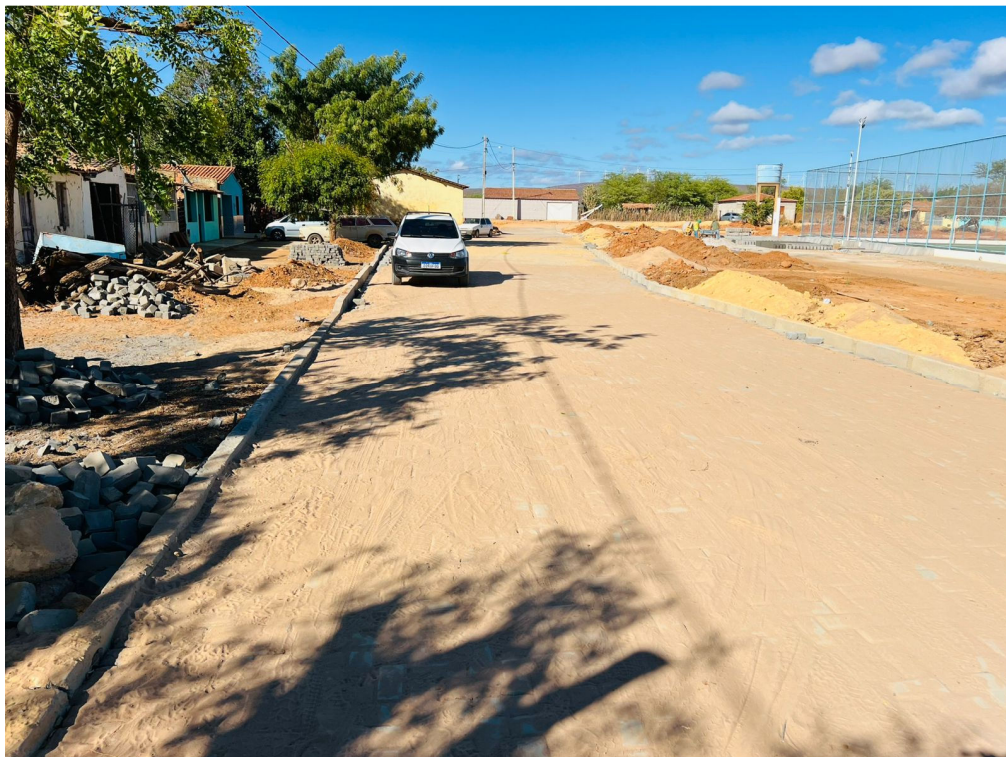
IMAGEM 03: PAVIMENTAÇÃO NO POVOADO DE TABATINGA ITAGUAÇU DA BAHIA - BAHIA
