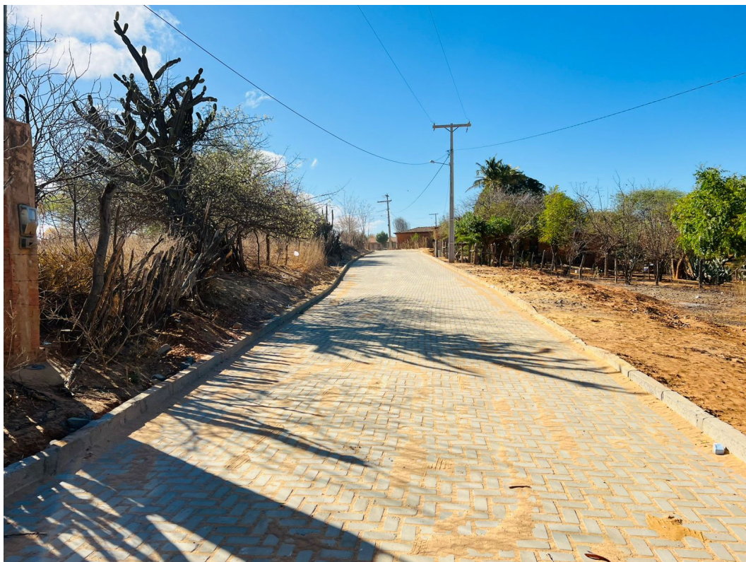
IMAGEM 13: PAVIMENTAÇÃO NO POVOADO DE TABATINGA ITAGUAÇU DA BAHIA - BAHIA
