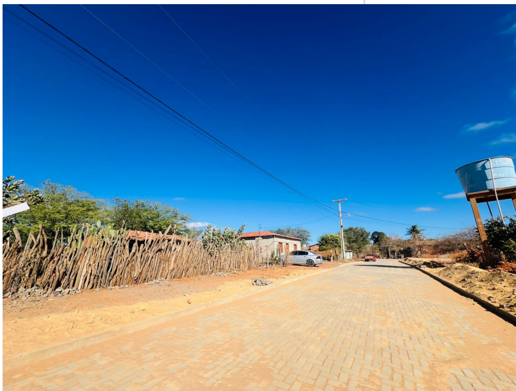
IMAGEM 06: PAVIMENTAÇÃO NO POVOADO DE TABATINGA ITAGUAÇU DA BAHIA - BAHIA
