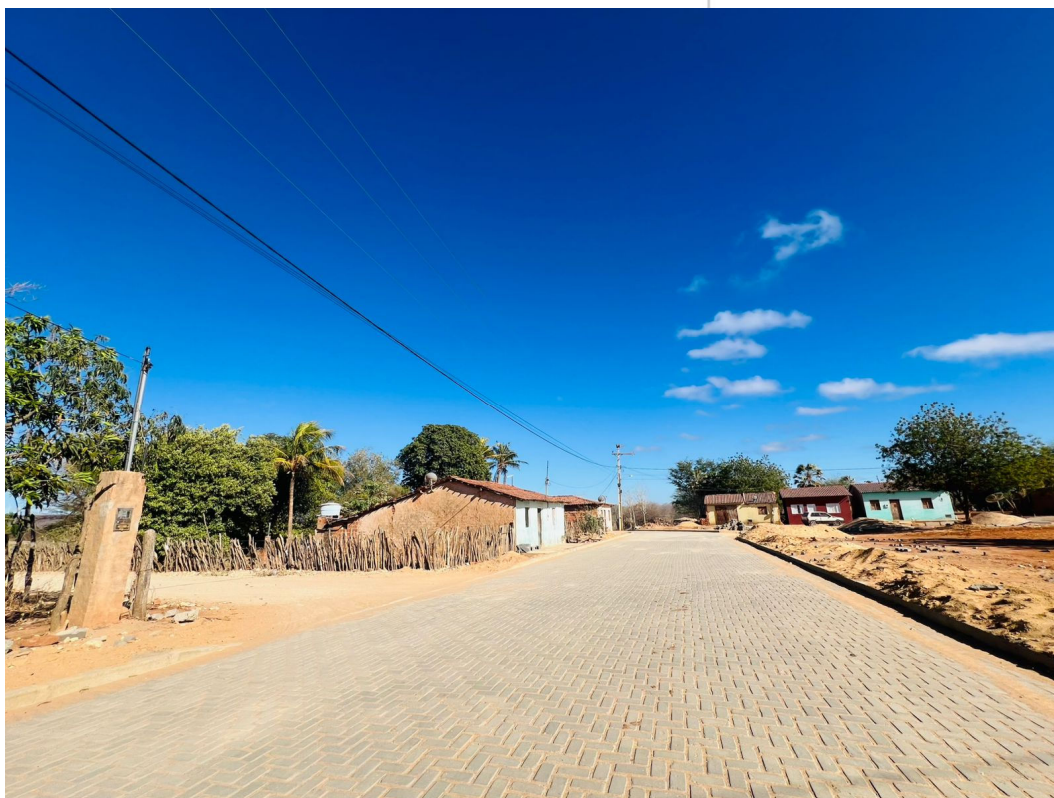
IMAGEM 10: PAVIMENTAÇÃO NO POVOADO DE TABATINGA ITAGUAÇU DA BAHIA - BAHIA
