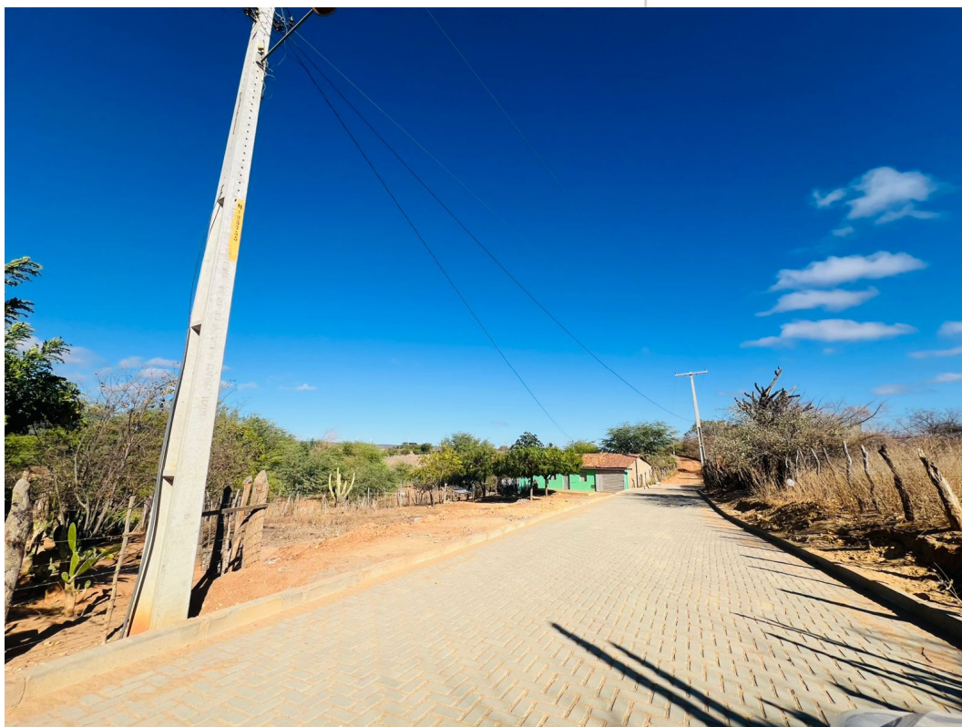
IMAGEM 12: PAVIMENTAÇÃO NO POVOADO DE TABATINGA ITAGUAÇU DA BAHIA - BAHIA
