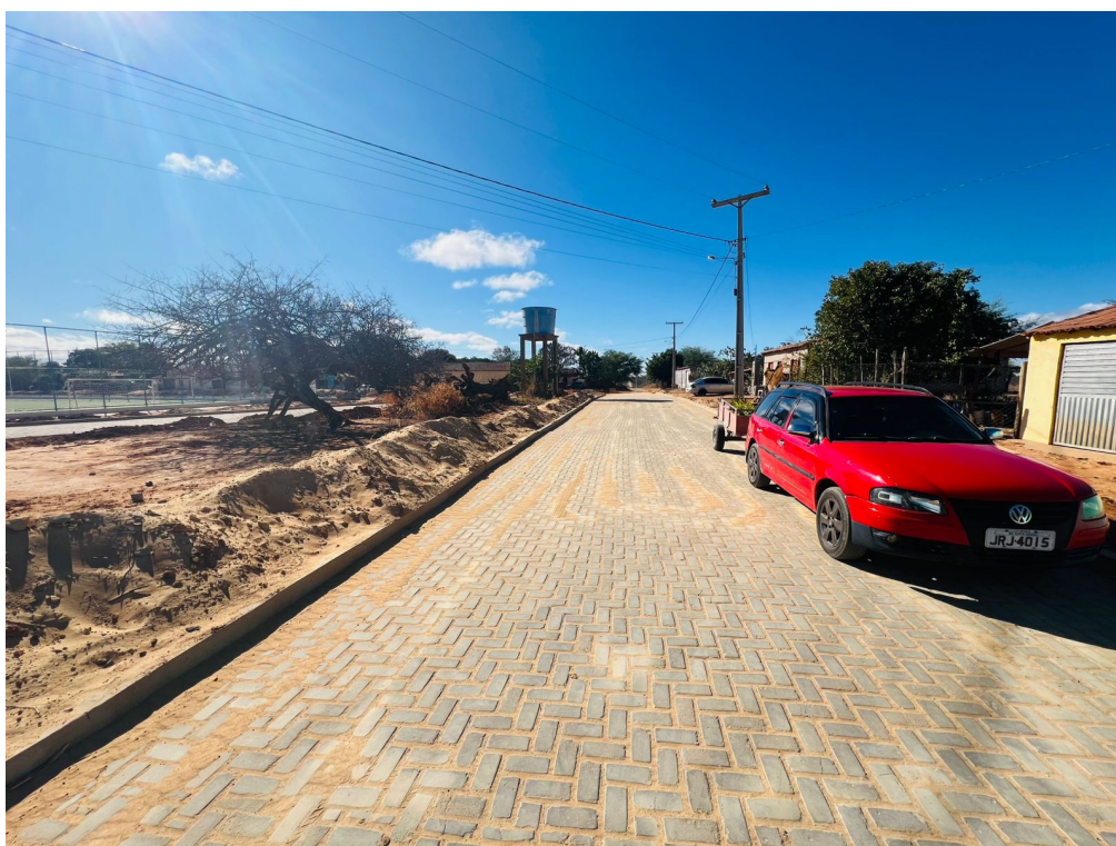
IMAGEM 07: PAVIMENTAÇÃO NO POVOADO DE TABATINGA ITAGUAÇU DA BAHIA - BAHIA
