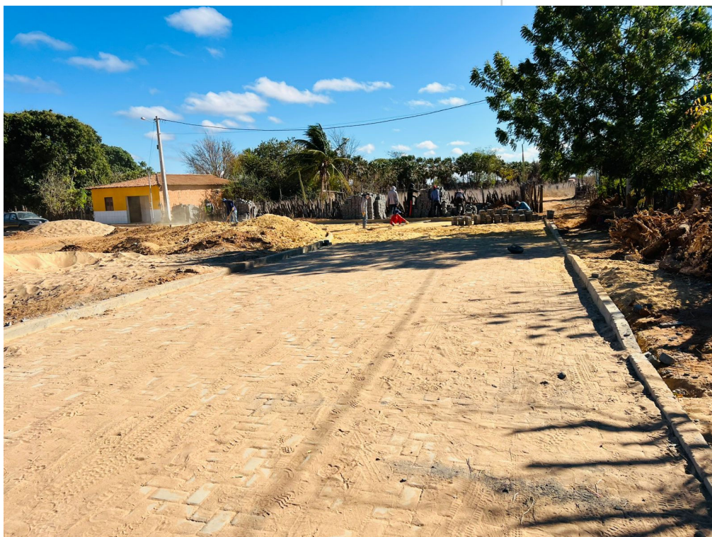
IMAGEM 02: PAVIMENTAÇÃO NO POVOADO DE TABATINGA ITAGUAÇU DA BAHIA - BAHIA
