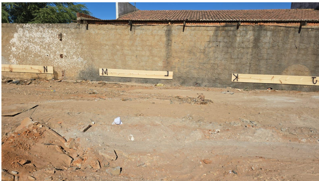
Figura 13: Locação com gabarito de tábuas
