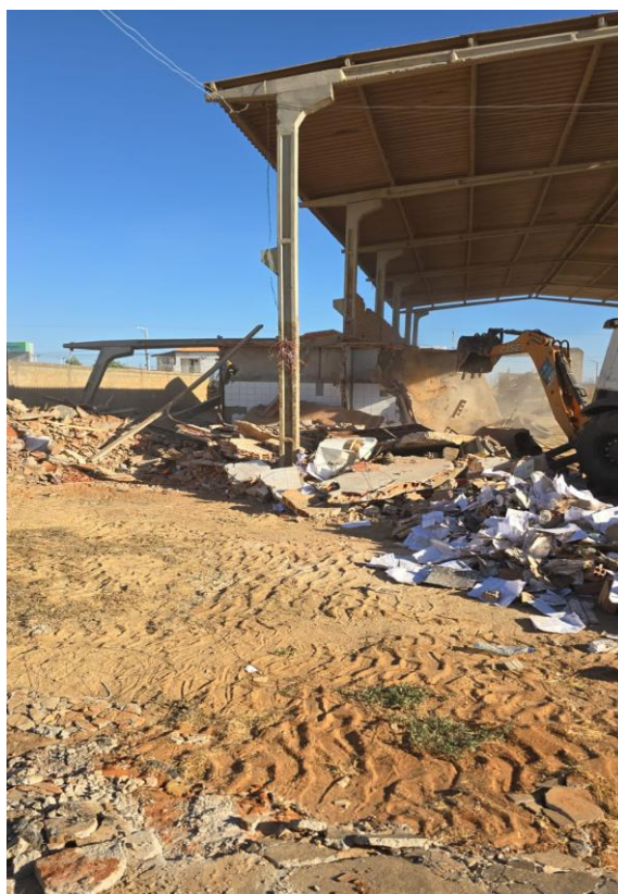
Figura 3: Demolição de alvenaria
