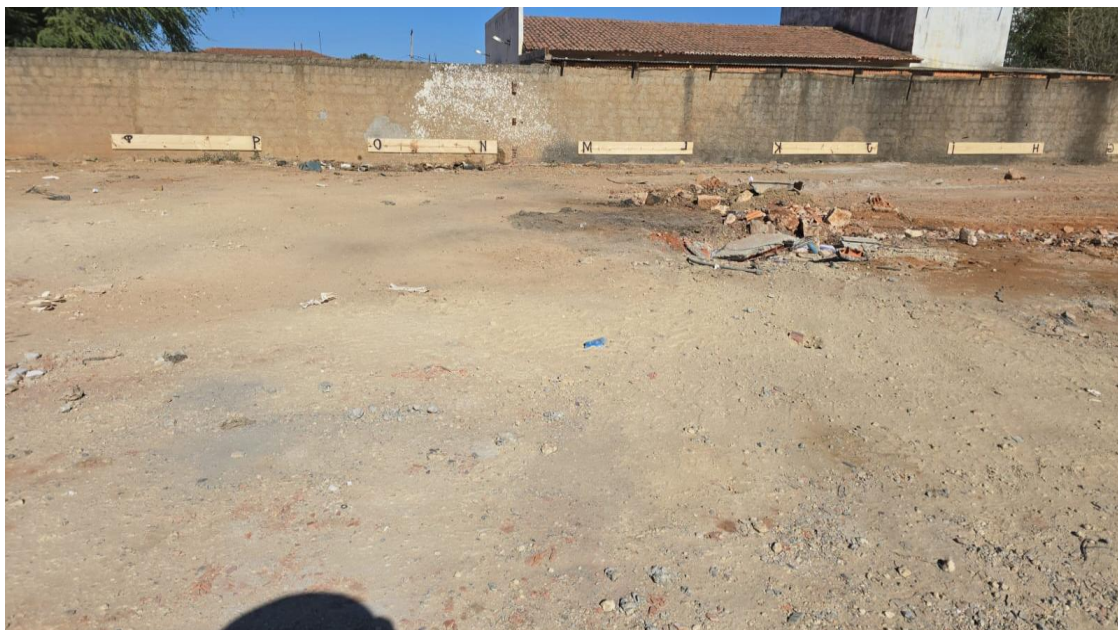
Figura 15: Locação com gabarito de tábuas
