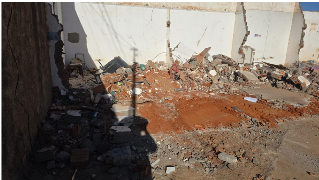
Figura 2: Demolição de alvenaria e piso
