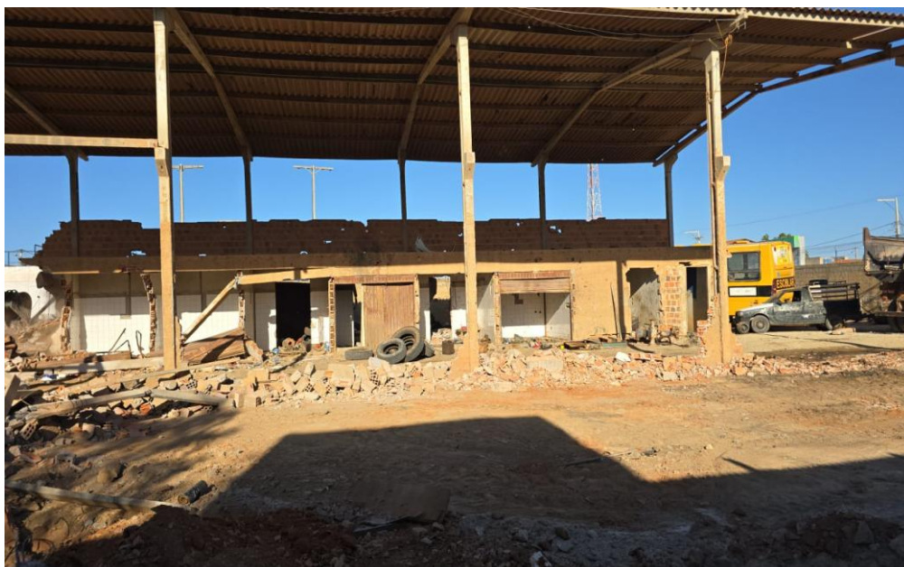
Figura 6: Demolição de alvenaria e transporte com caminhão
