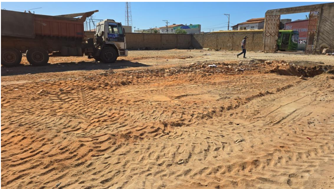
Figura 9: Transporte com caminhão (bota fora)
