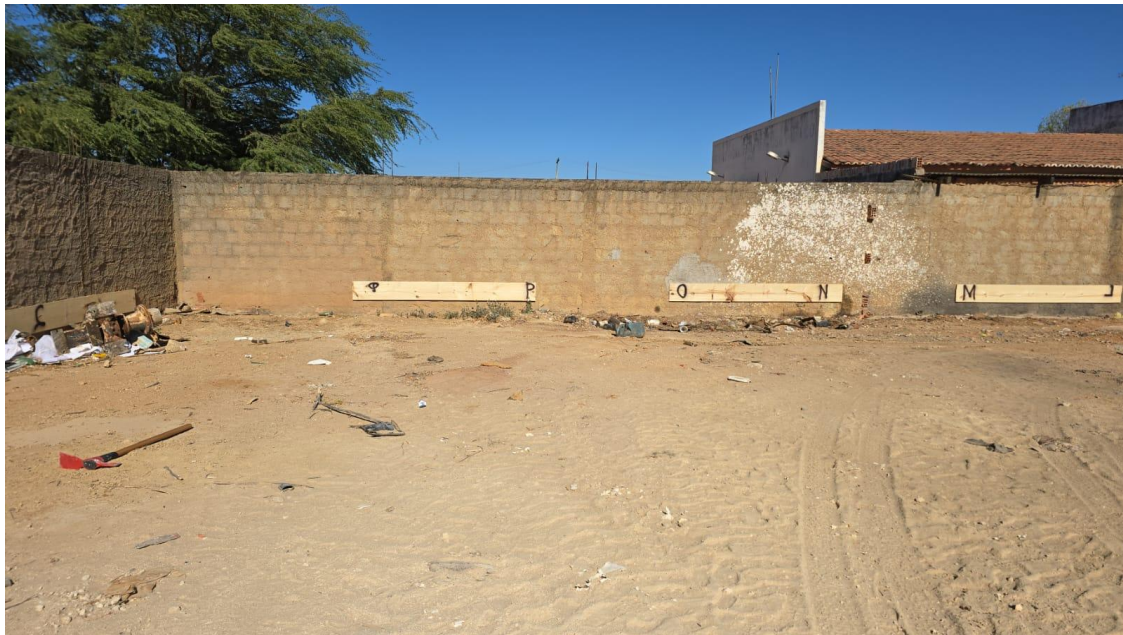
Figura 14: Locação com gabarito de tábuas
