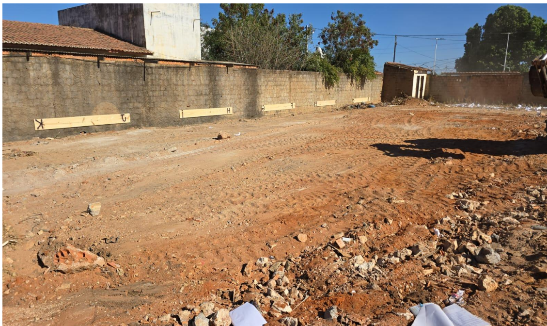
Figura 11: Locação com gabarito de tábuas
