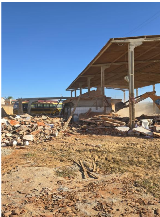
Figura 4: Demolição de alvenaria
