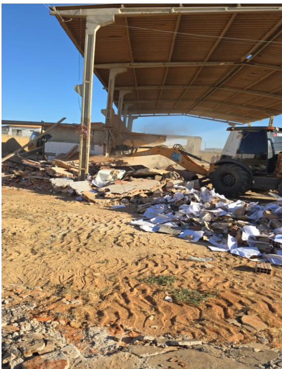
Figura 5: Demolição de alvenaria e remoção de telhas
