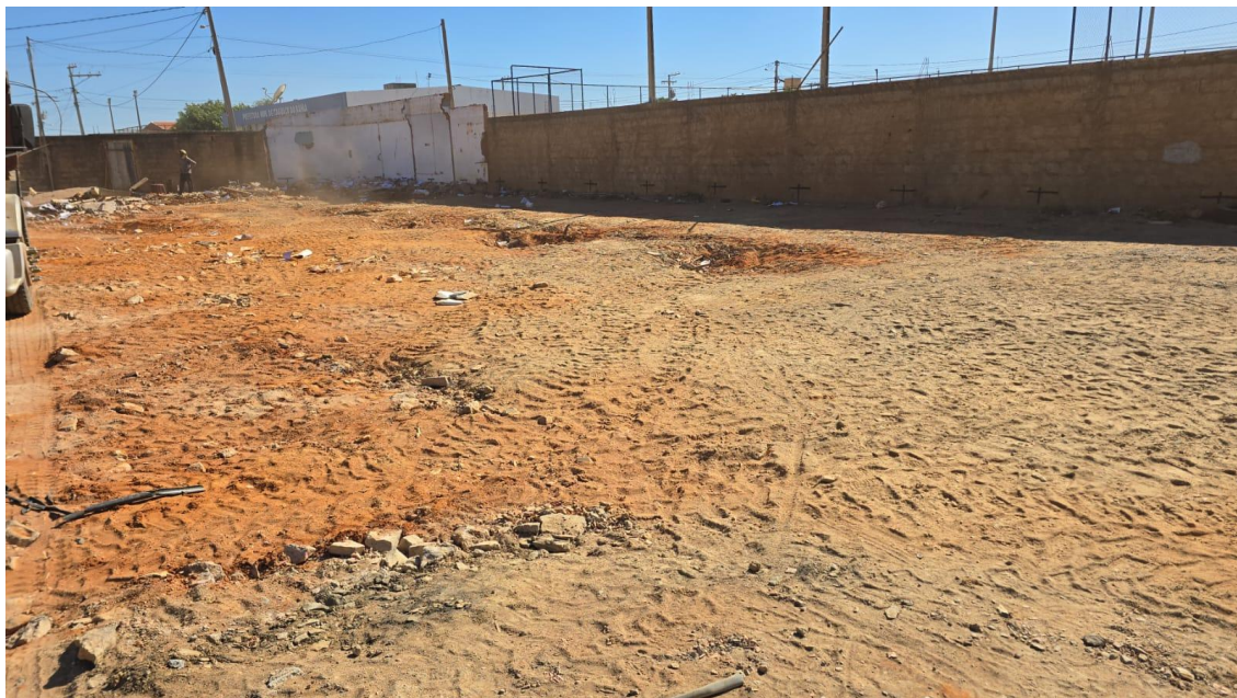
Figura 10: Transporte com caminhão (bota fora)
