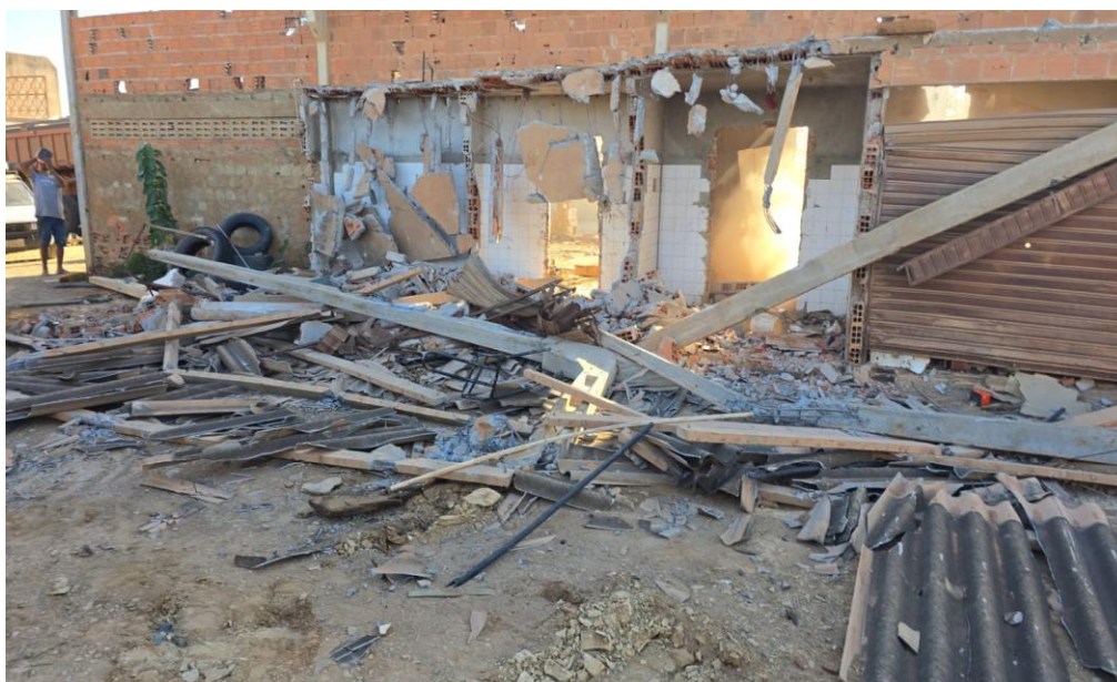
Figura 7: Demolição de alvenaria e remoção de portas
