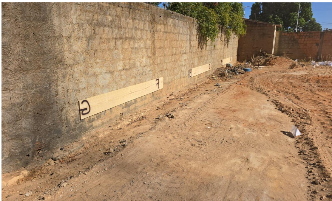
Figura 12: Locação com gabarito de tábuas
