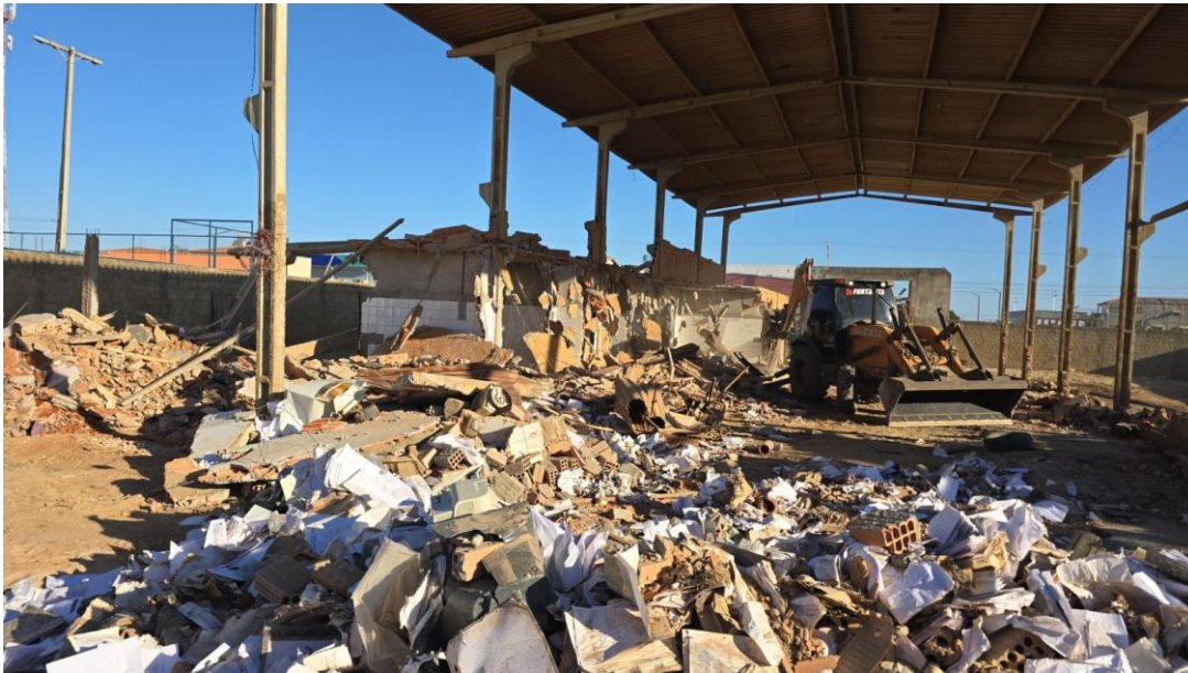
Figura 8: Demolição de alvenaria e piso
