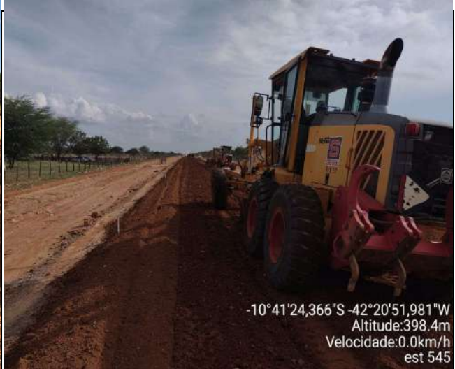
EXECUÇÃO DE BASE
