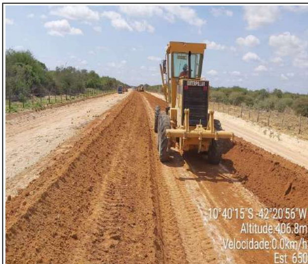
EXECUÇÃO DE BASE
