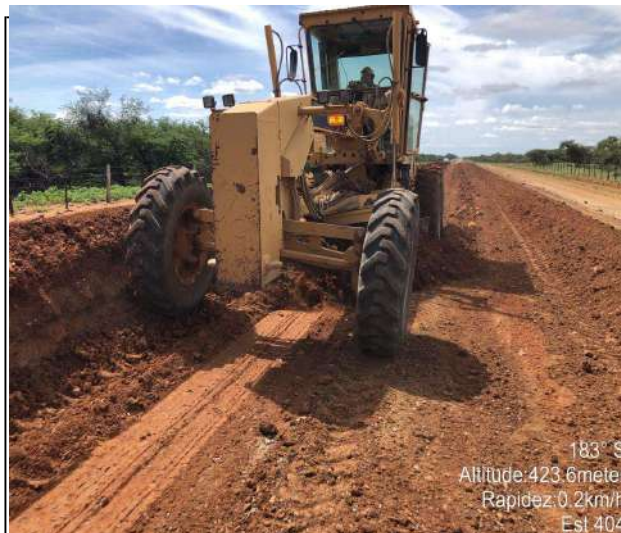
EXECUÇÃO DE BASE
