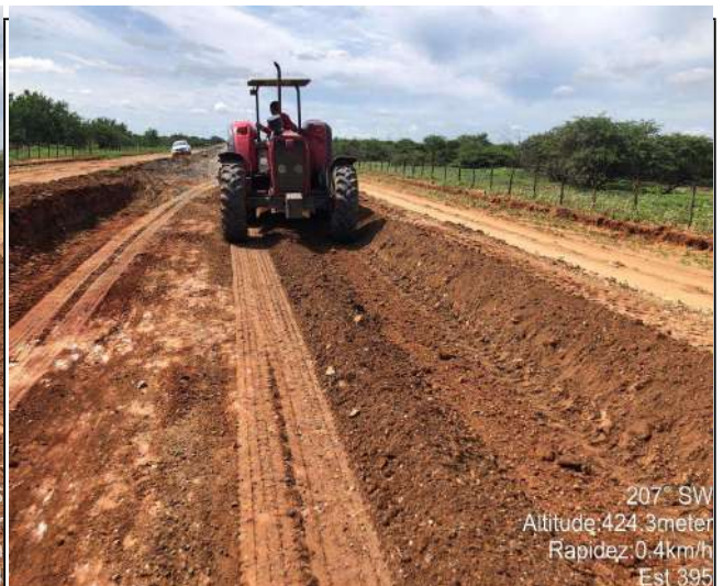
EXECUÇÃO DE BASE
