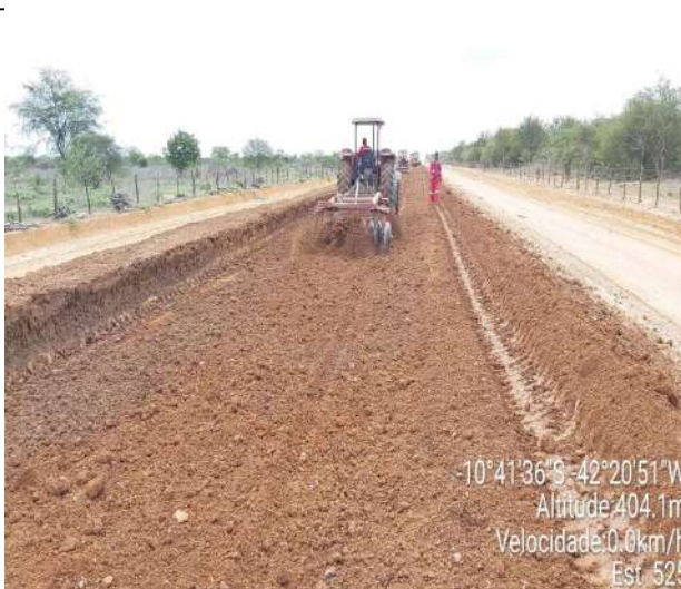
EXECUÇÃO DE BASE
