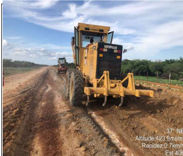
EXECUÇÃO DE BASE
