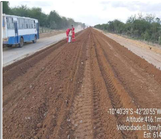
EXECUÇÃO DE BASE
