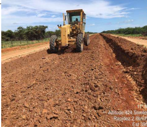
EXECUÇÃO DE BASE
