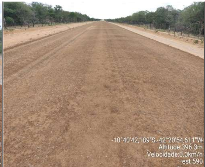
EXECUÇÃO DE BASE
