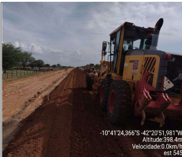
EXECUÇÃO DE BASE
