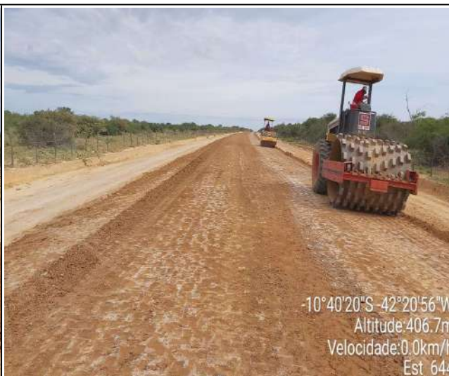
EXECUÇÃO DE BASE
