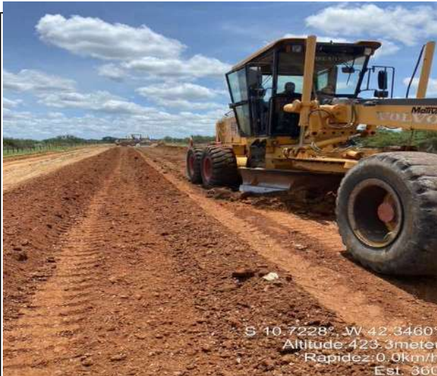
EXECUÇÃO DE BASE
