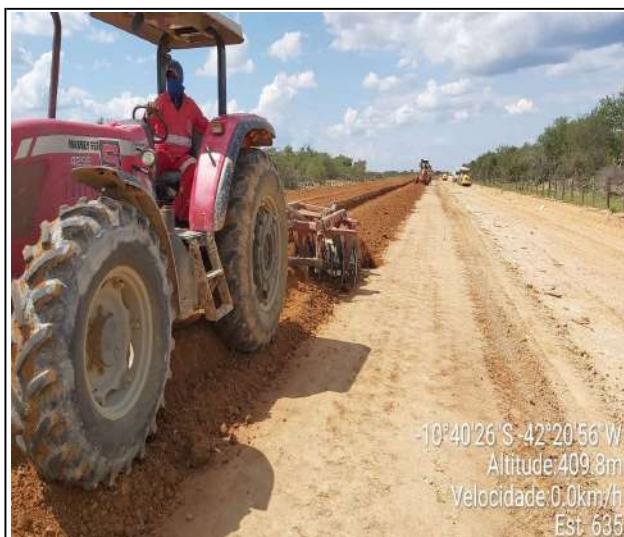
EXECUÇÃO DE BASE
