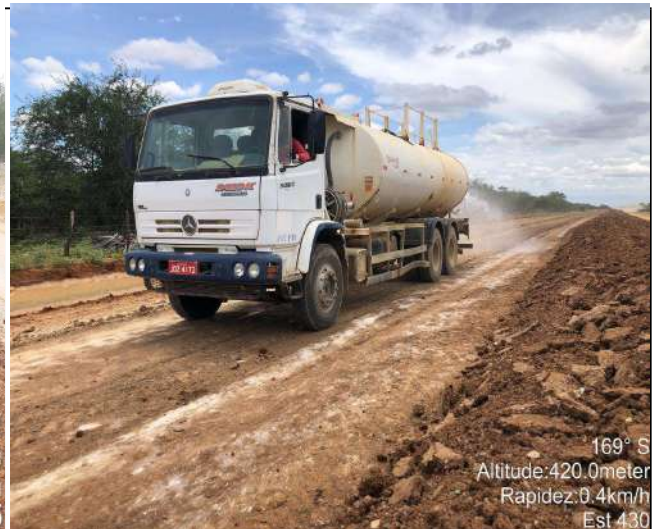
EXECUÇÃO DE BASE
