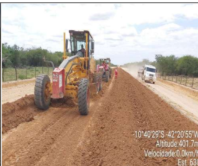
EXECUÇÃO DE BASE
