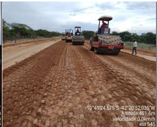
EXECUÇÃO DE BASE
