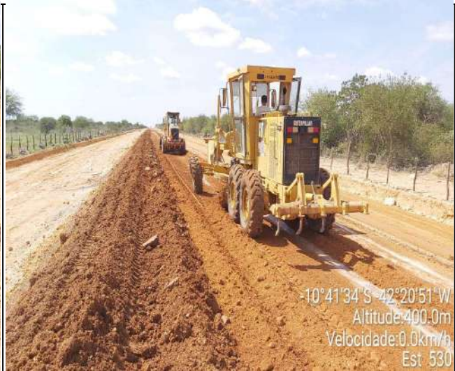
EXECUÇÃO DE BASE
