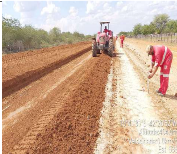
EXECUÇÃO DE BASE
