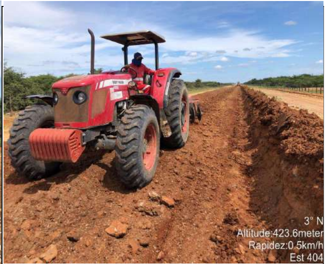
EXECUÇÃO DE BASE
