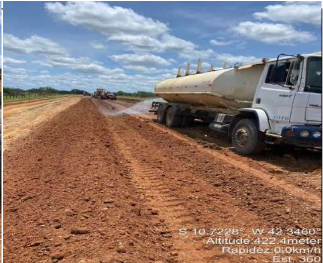
EXECUÇÃO DE BASE
