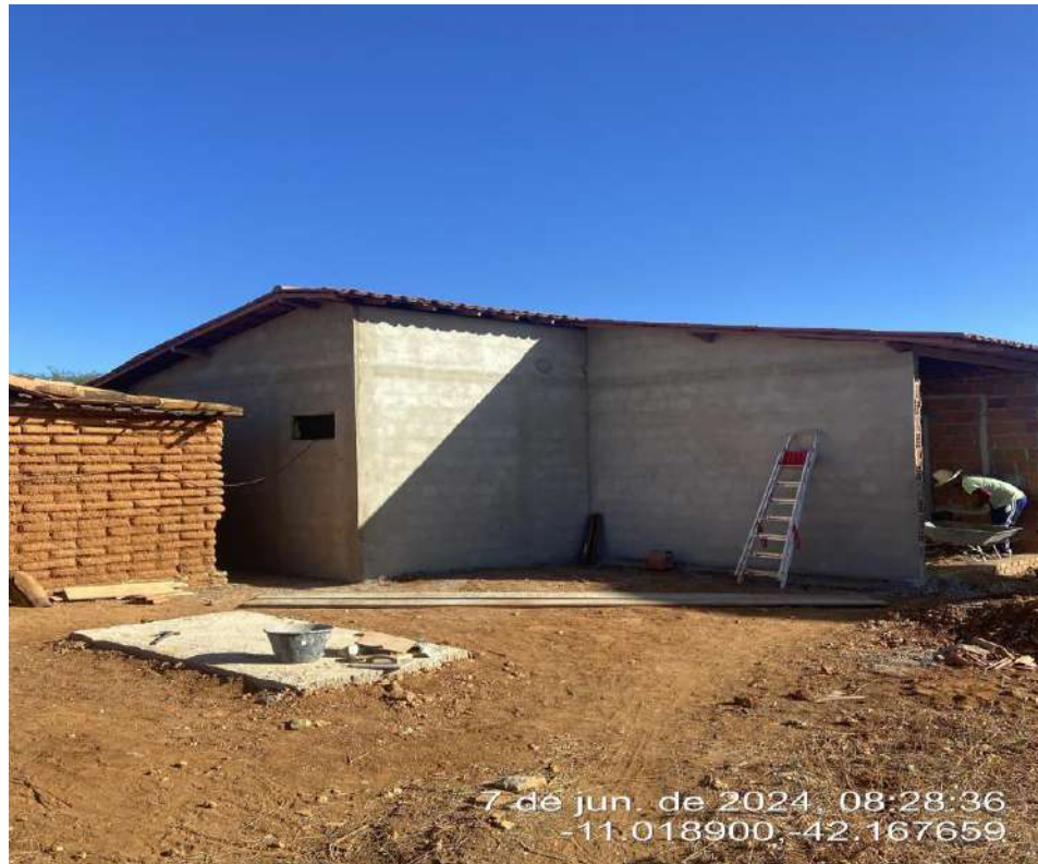
FOTO 14: MELHORIAS HABITACIONAIS PARA O CONTROLE DA DOENÇA DE CHAGAS NO MUNICIPIO DE ITAGUAÇU DA BAHIA-BA.
