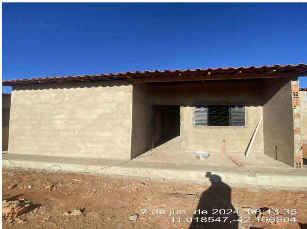
FOTO 04: MELHORIAS HABITACIONAIS PARA O CONTROLE DA DOENÇA DE CHAGAS NO MUNICIPIO DE ITAGUAÇU DA BAHIA-BA.
