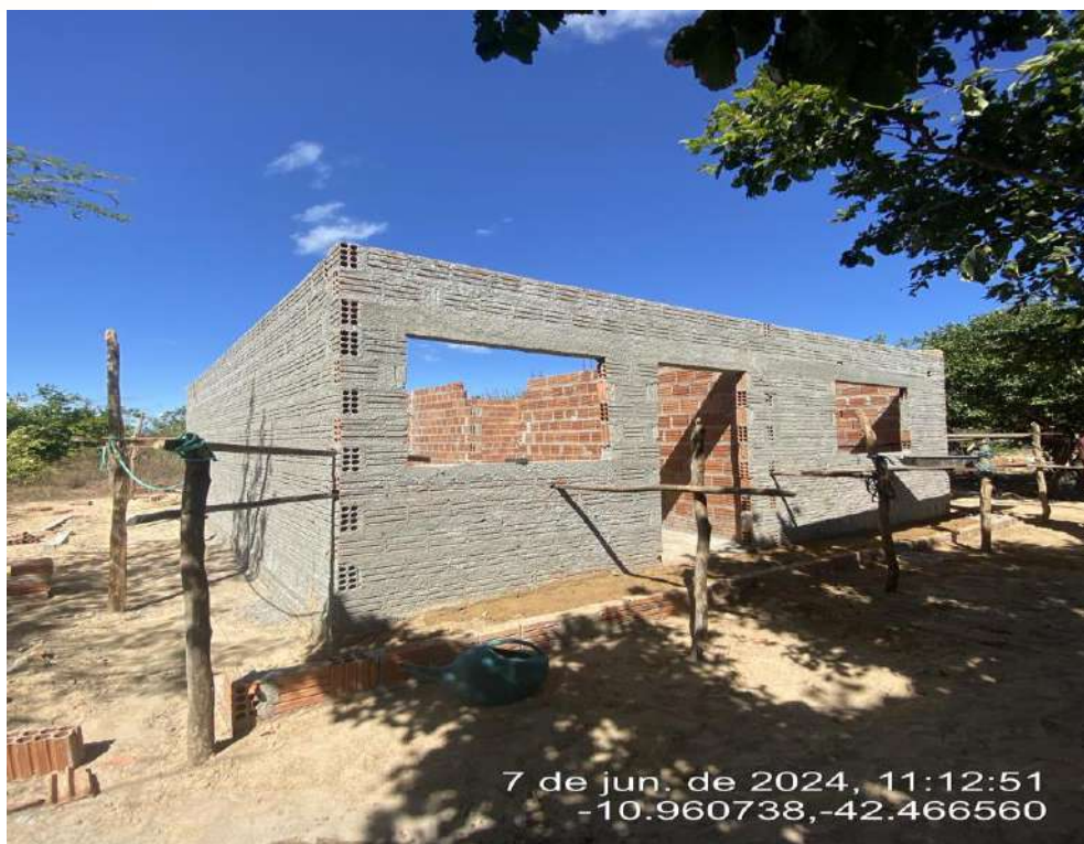
FOTO 27: MELHORIAS HABITACIONAIS PARA O CONTROLE DA DOENÇA DE CHAGAS NO MUNICIPIO DE ITAGUAÇU DA BAHIA-BA.
