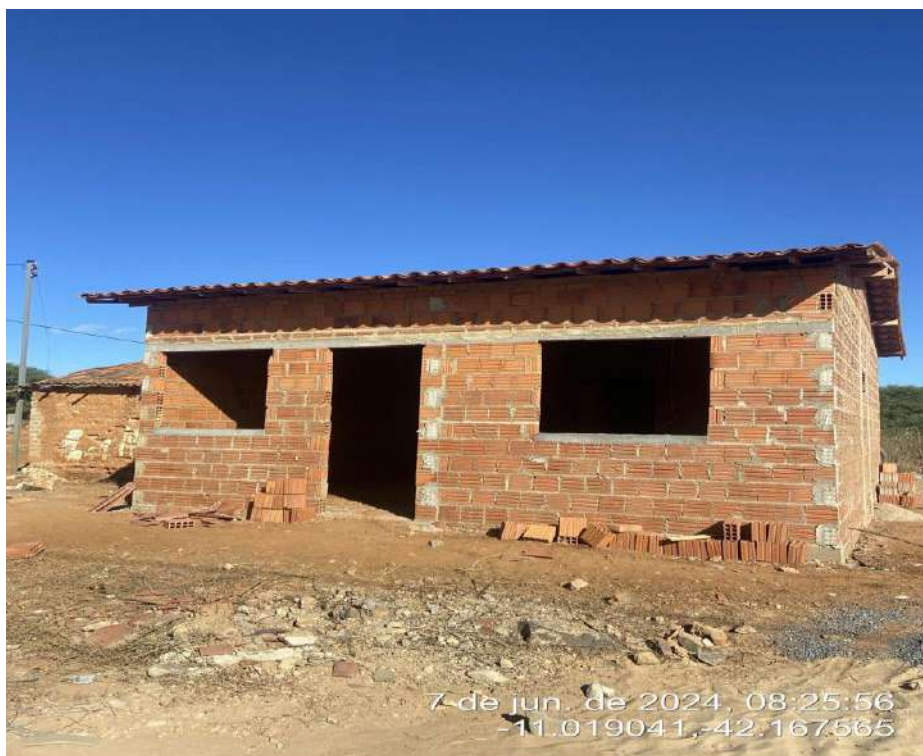
FOTO 06: MELHORIAS HABITACIONAIS PARA O CONTROLE DA DOENÇA DE CHAGAS NO MUNICIPIO DE ITAGUAÇU DA BAHIA-BA.
