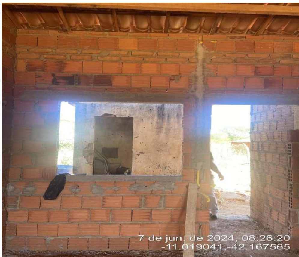
FOTO 09: MELHORIAS HABITACIONAIS PARA O CONTROLE DA DOENÇA DE CHAGAS NO MUNICIPIO DE ITAGUAÇU DA BAHIA-BA.
