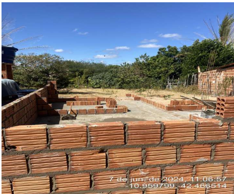
FOTO 25: MELHORIAS HABITACIONAIS PARA O CONTROLE DA DOENÇA DE CHAGAS NO MUNICIPIO DE ITAGUAÇU DA BAHIA-BA.
