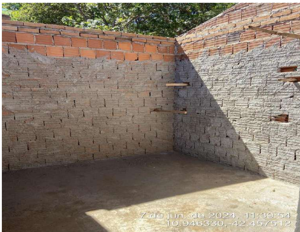
FOTO 30: MELHORIAS HABITACIONAIS PARA O CONTROLE DA DOENÇA DE CHAGAS NO MUNICIPIO DE ITAGUAÇU DA BAHIA-BA.
