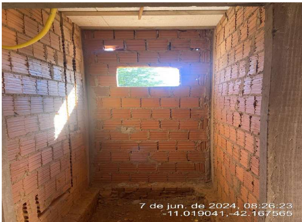
FOTO 12: MELHORIAS HABITACIONAIS PARA O CONTROLE DA DOENÇA DE CHAGAS NO MUNICIPIO DE ITAGUAÇU DA BAHIA-BA.
