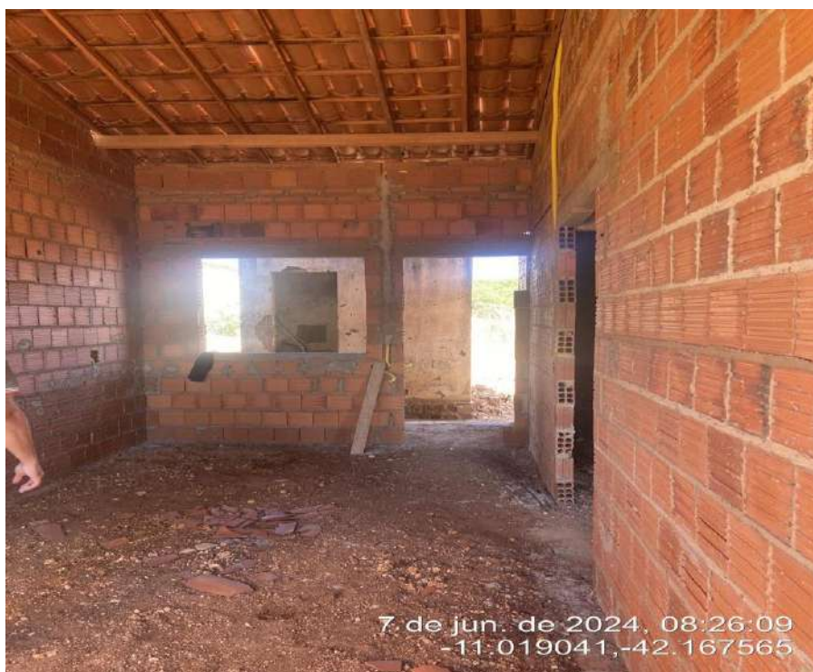
FOTO 08: MELHORIAS HABITACIONAIS PARA O CONTROLE DA DOENÇA DE CHAGAS NO MUNICIPIO DE ITAGUAÇU DA BAHIA-BA.
