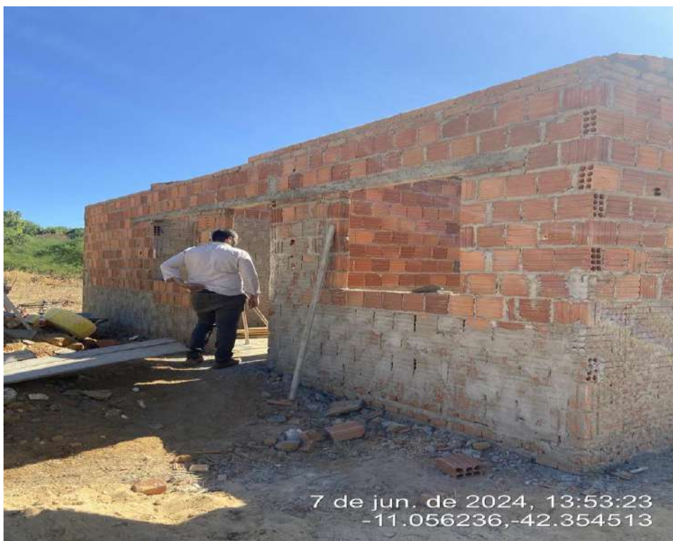
FOTO 31: MELHORIAS HABITACIONAIS PARA O CONTROLE DA DOENÇA DE CHAGAS NO MUNICIPIO DE ITAGUAÇU DA BAHIA-BA.
