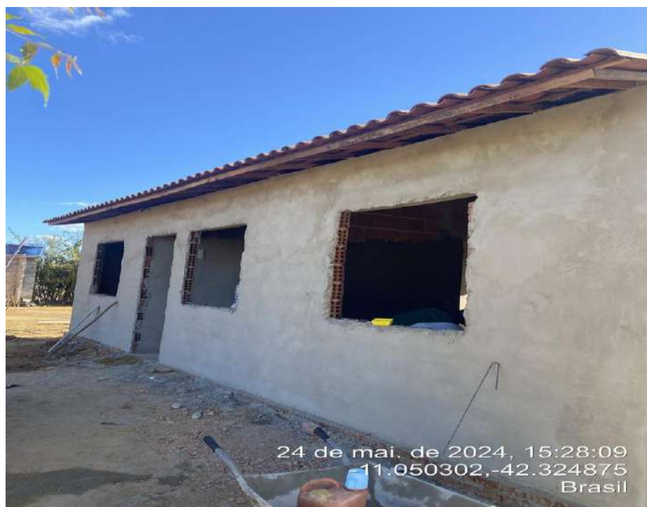
FOTO 38: MELHORIAS HABITACIONAIS PARA O CONTROLE DA DOENÇA DE CHAGAS NO MUNICIPIO DE ITAGUAÇU DA BAHIA-BA.
