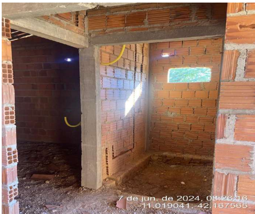
FOTO 07: MELHORIAS HABITACIONAIS PARA O CONTROLE DA DOENÇA DE CHAGAS NO MUNICIPIO DE ITAGUAÇU DA BAHIA-BA.
