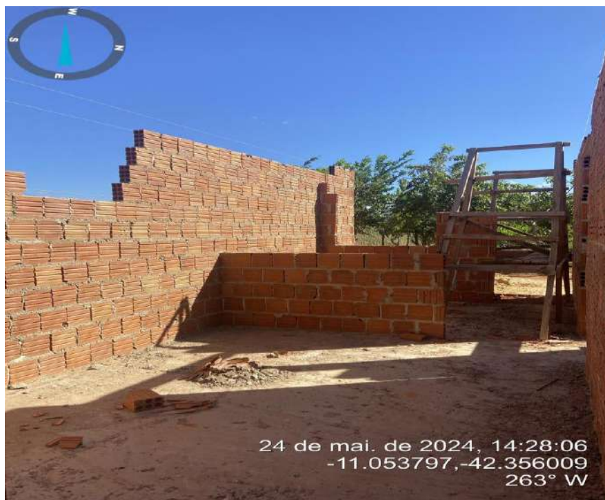
FOTO 34: MELHORIAS HABITACIONAIS PARA O CONTROLE DA DOENÇA DE CHAGAS NO MUNICIPIO DE ITAGUAÇU DA BAHIA-BA.
