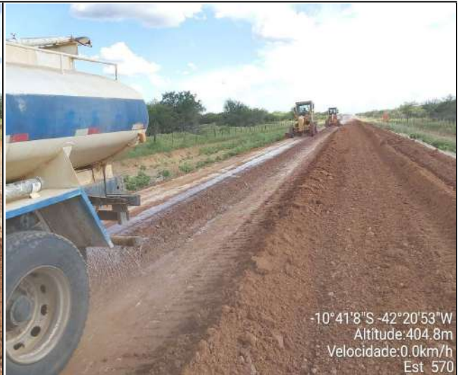
EXECUÇÃO DE BASE
