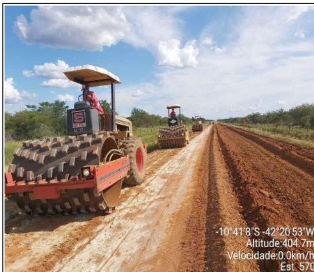
EXECUÇÃO DE BASE
