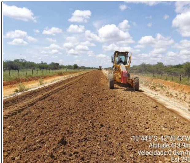
EXECUÇÃO DE BASE 270 a 300
