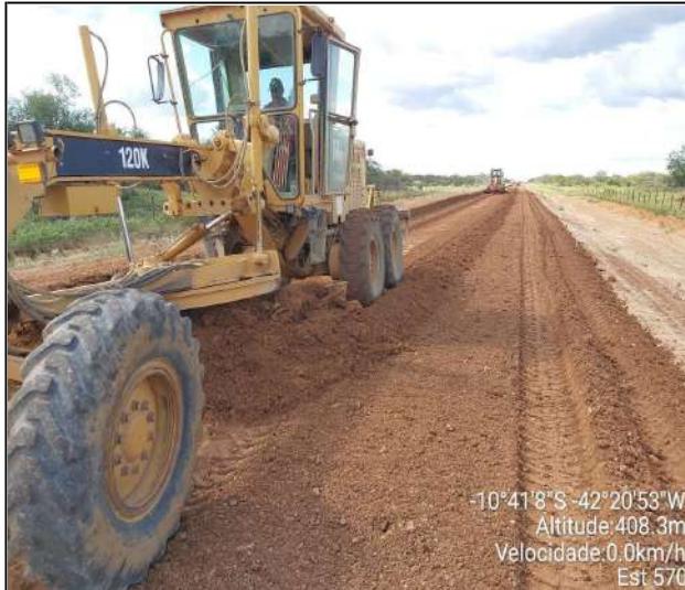
EXECUÇÃO DE BASE
