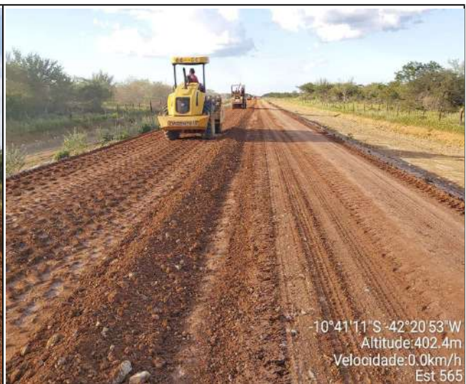
EXECUÇÃO DE BASE
