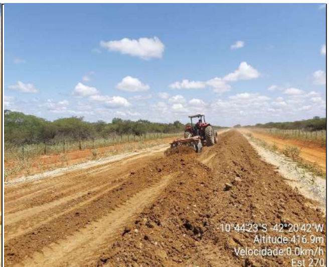
EXECUÇÃO DE BASE
