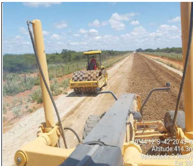
EXECUÇÃO DE BASE
