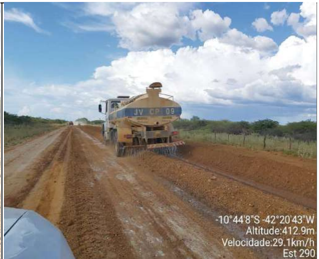
EXECUÇÃO DE BASE
