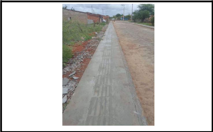
FOTO 01 - EXECUÇÃO DE SERVIÇOS DE PAVIMENTAÇÃO EM INTERTRAVADO NO MUNICÍPIO DE ITAGUAÇU/BA
