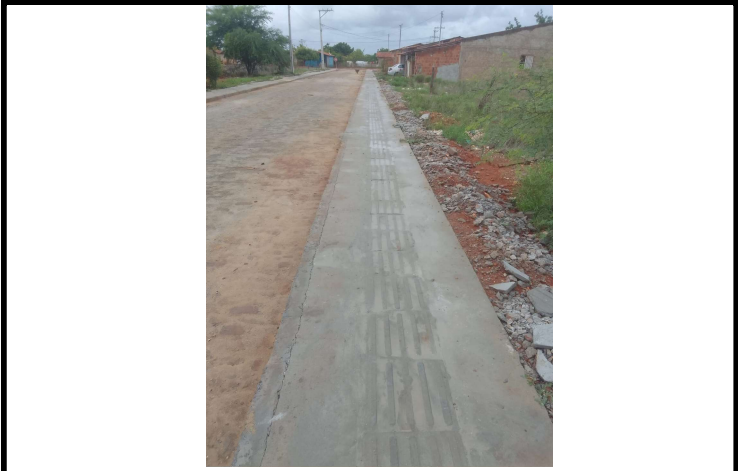
FOTO 03 - EXECUÇÃO DE SERVIÇOS DE PAVIMENTAÇÃO EM INTERTRAVADO NO MUNICÍPIO DE ITAGUAÇU/BA
