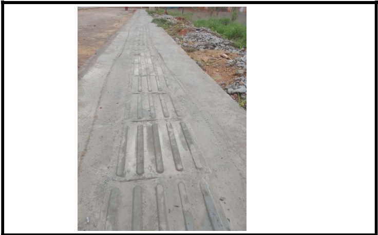
FOTO 02 - EXECUÇÃO DE SERVIÇOS DE PAVIMENTAÇÃO EM INTERTRAVADO NO MUNICÍPIO DE ITAGUAÇU/BA
