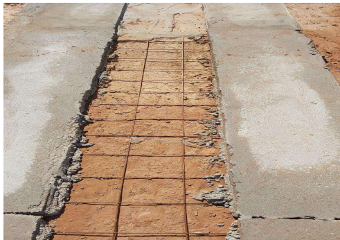
FOTO 06 - EXECUÇÃO DE SERVIÇOS DE PAVIMENTAÇÃO EM INTERTRAVADO NO MUNICÍPIO DE ITAGUAÇU/BA
