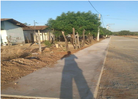
FOTO 05 - EXECUÇÃO DE SERVIÇOS DE PAVIMENTAÇÃO EM INTERTRAVADO NO MUNICÍPIO DE ITAGUAÇU/BA
