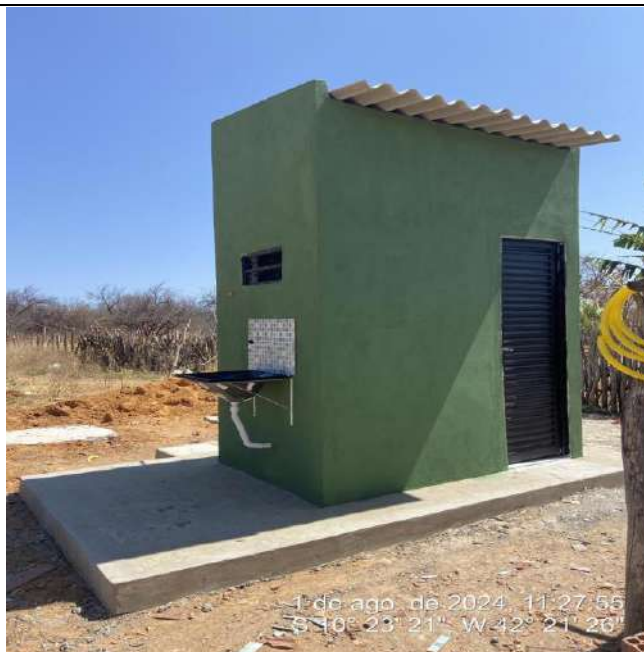
MELHORIAS SANITÁRIAS DOMICIAIS NO MUNICÍPIO DE ITAGUAÇU DA BAHIA-BA.
