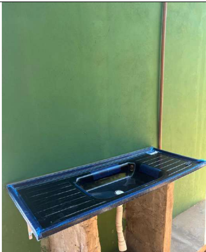
MELHORIAS SANITÁRIAS DOMICIAIS NO MUNICÍPIO DE ITAGUAÇU DA BAHIA-BA.
