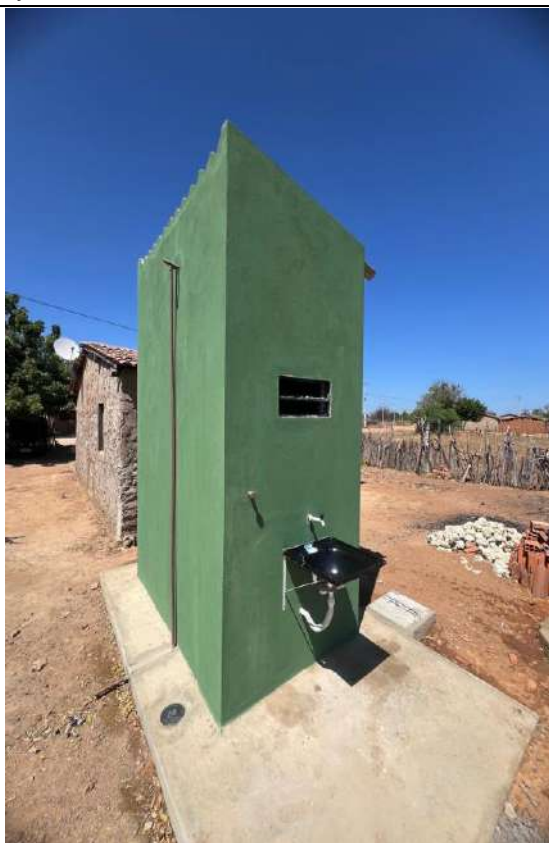
MELHORIAS SANITÁRIAS DOMICIAIS NO MUNICÍPIO DE ITAGUAÇU DA BAHIA-BA.
