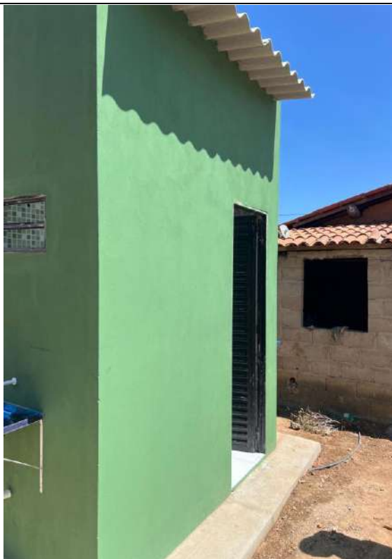
MELHORIAS SANITÁRIAS DOMICIAIS NO MUNICÍPIO DE ITAGUAÇU DA BAHIA-BA.
