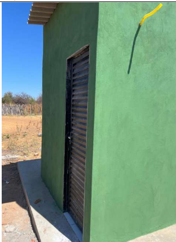
MELHORIAS SANITÁRIAS DOMICIAIS NO MUNICÍPIO DE ITAGUAÇU DA BAHIA-BA.
