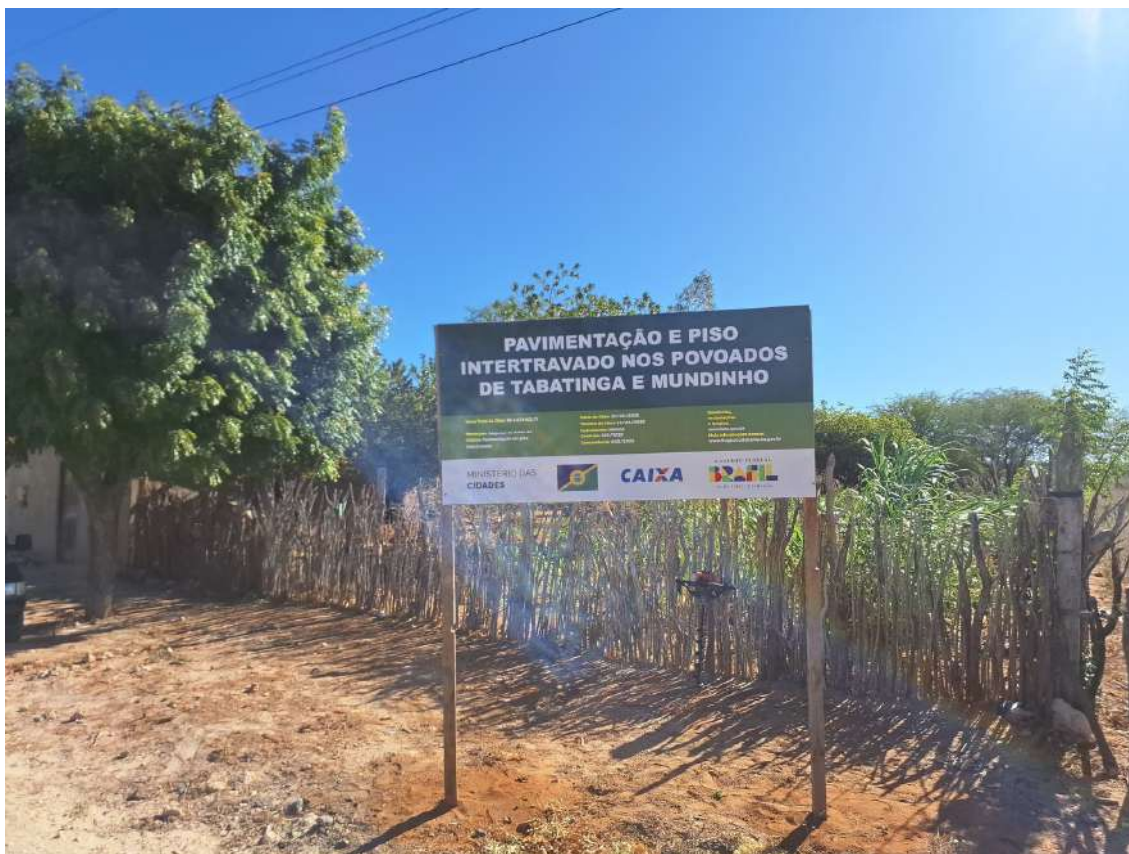
IMAGEM 01: PLACA DA OBRA DE PAVIMENTAÇÃO NO POVOADO DE MUNDINHO/TABATINGA ITAGUAÇU DA BAHIA - BAHIA
