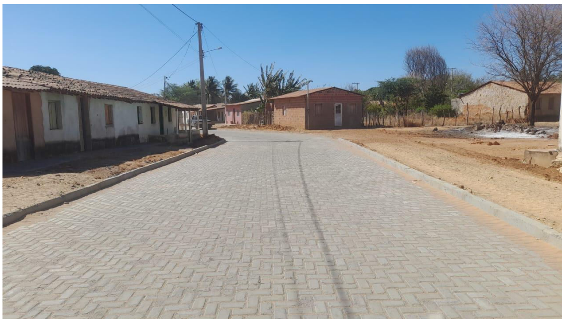
IMAGEM 02: PAVIMENTAÇÃO NO POVOADO DE TABATINGA ITAGUAÇU DA BAHIA - BAHIA
