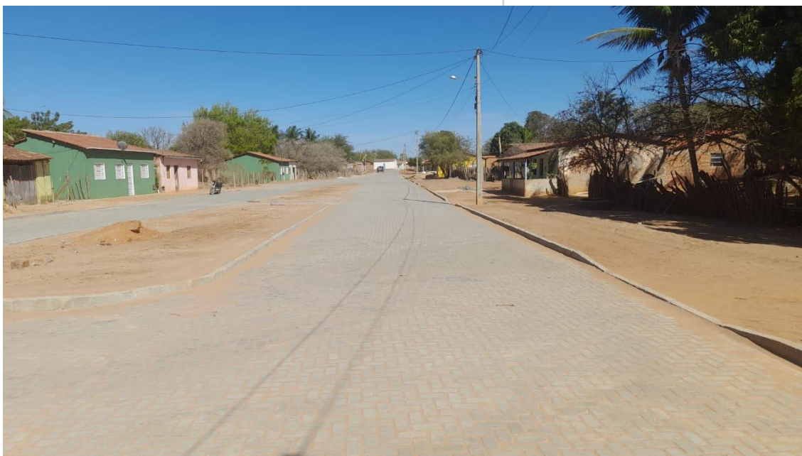
IMAGEM 08: PAVIMENTAÇÃO NO POVOADO DE TABATINGA ITAGUAÇU DA BAHIA - BAHIA
