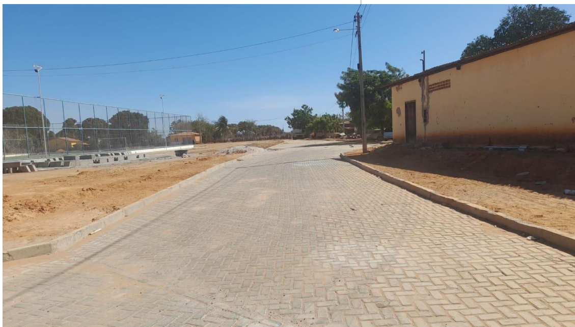
IMAGEM 12: PAVIMENTAÇÃO NO POVOADO DE TABATINGA ITAGUAÇU DA BAHIA - BAHIA
