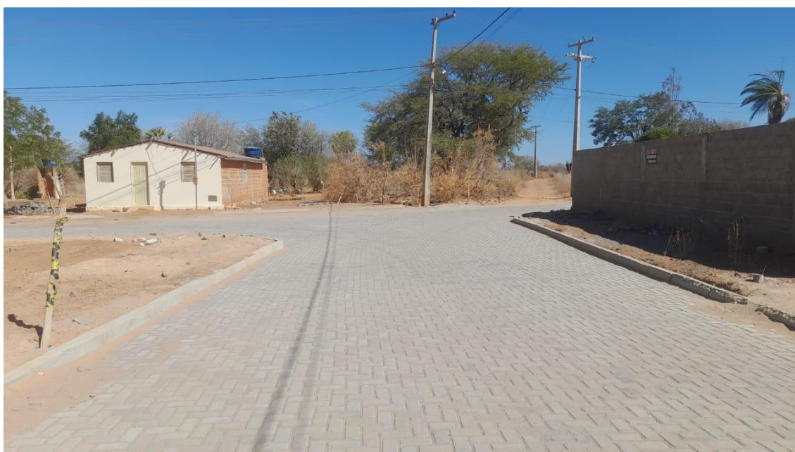
IMAGEM 03: PAVIMENTAÇÃO NO POVOADO DE TABATINGA ITAGUAÇU DA BAHIA - BAHIA
