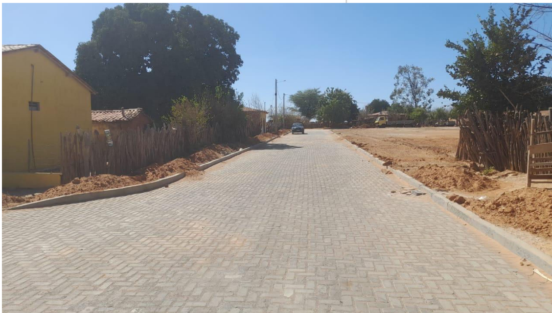
IMAGEM 10: PAVIMENTAÇÃO NO POVOADO DE TABATINGA ITAGUAÇU DA BAHIA - BAHIA
