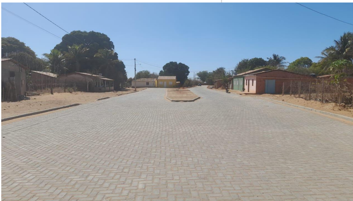
IMAGEM 06: PAVIMENTAÇÃO NO POVOADO DE TABATINGA ITAGUAÇU DA BAHIA - BAHIA
