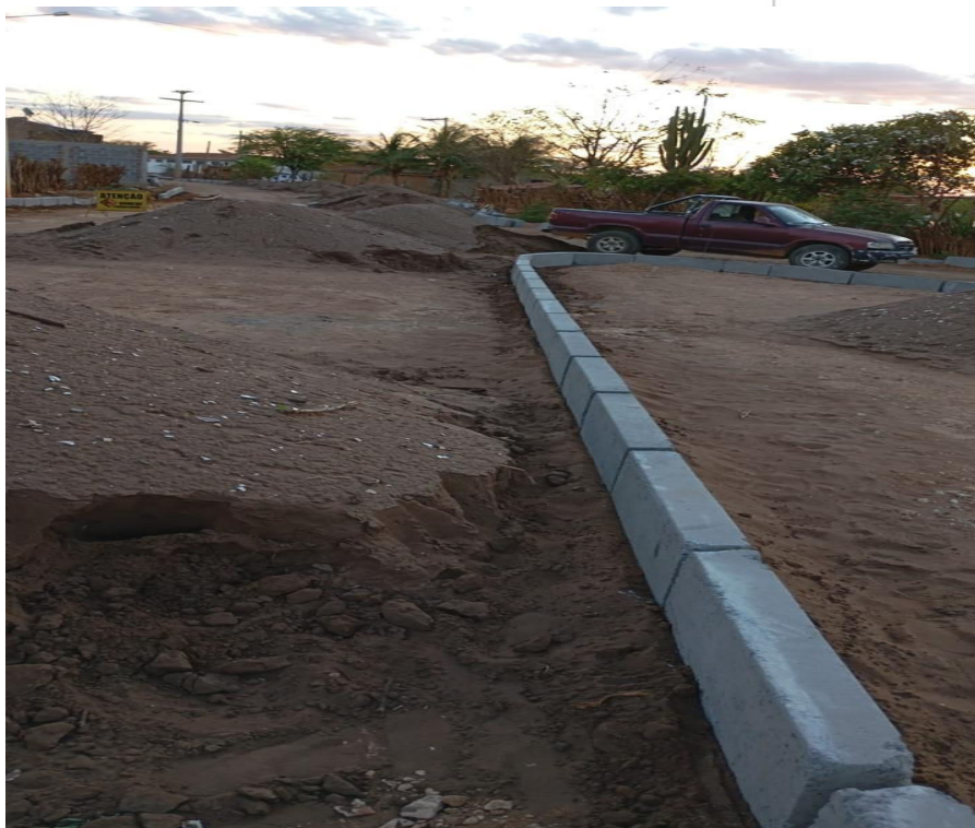
IMAGEM 22: PAVIMENTAÇÃO NO POVOADO DE MUNDINHO, ITAGUAÇU DA BAHIA - BAHIA
