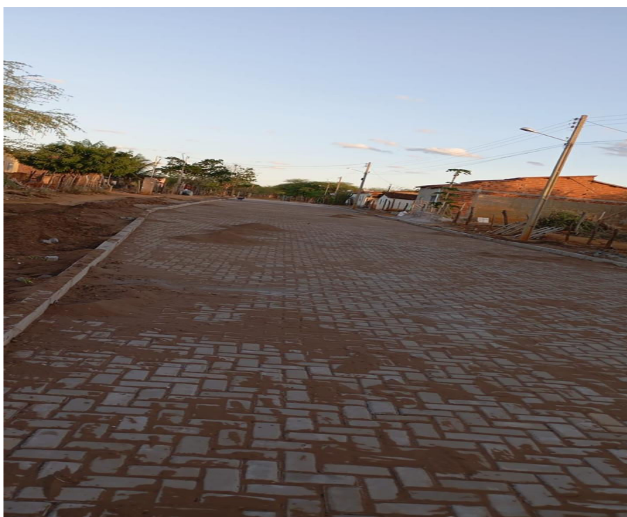
IMAGEM 20: PAVIMENTAÇÃO NO POVOADO DE MUNDINHO, ITAGUAÇU DA BAHIA - BAHIA
