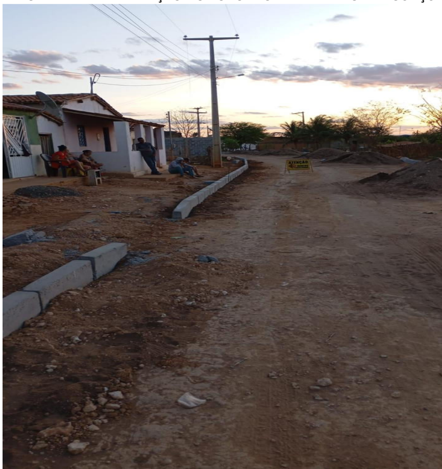
IMAGEM 14: PAVIMENTAÇÃO NO POVOADO DE MUNDINHO, ITAGUAÇU DA BAHIA - BAHIA
