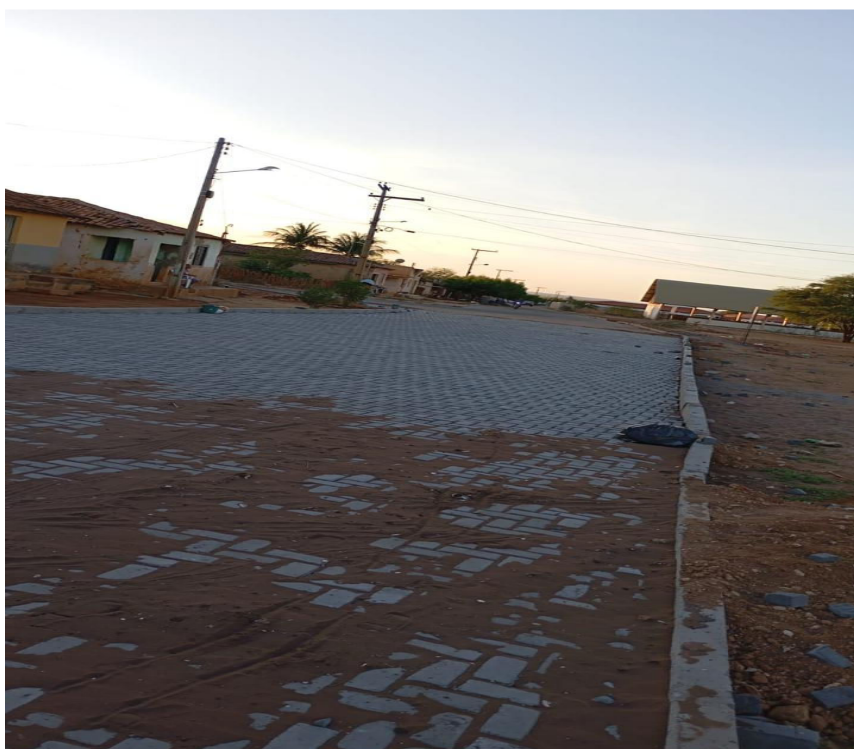
IMAGEM 18: PAVIMENTAÇÃO NO POVOADO DE MUNDINHO, ITAGUAÇU DA BAHIA - BAHIA
