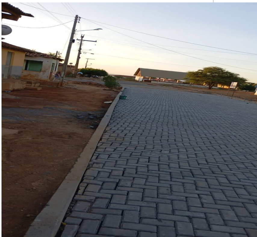
IMAGEM 17: PAVIMENTAÇÃO NO POVOADO DE MUNDINHO, ITAGUAÇU DA BAHIA - BAHIA
