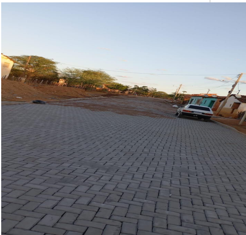
IMAGEM 15: PAVIMENTAÇÃO NO POVOADO DE MUNDINHO, ITAGUAÇU DA BAHIA - BAHIA
