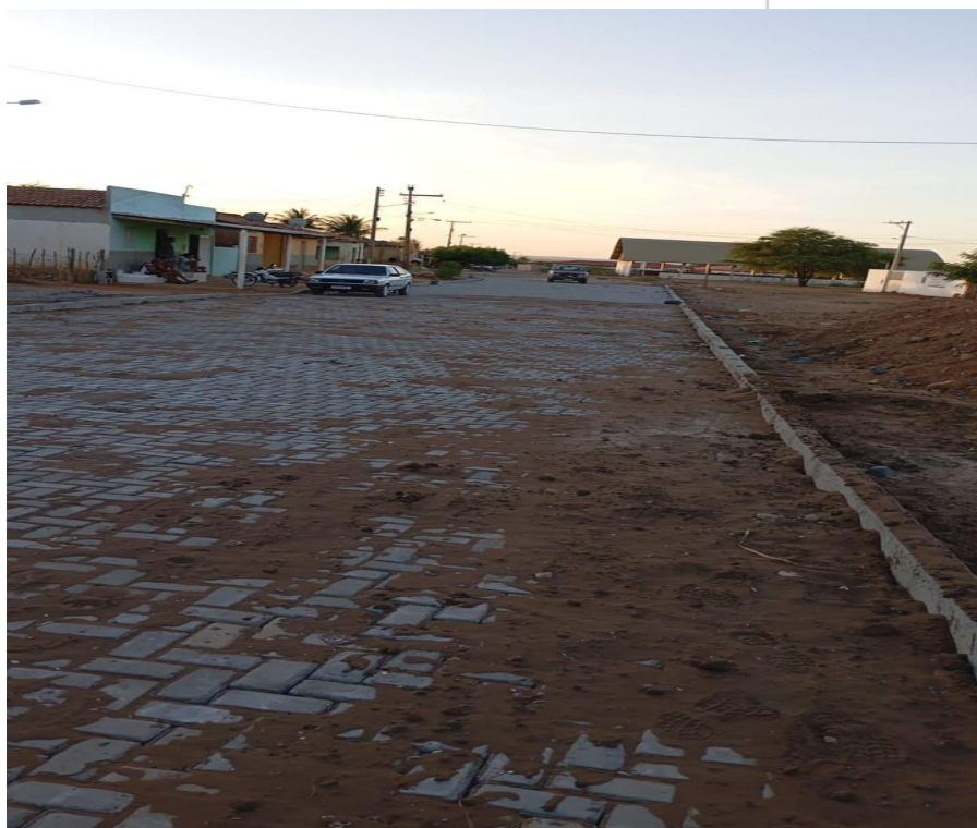
IMAGEM 19: PAVIMENTAÇÃO NO POVOADO DE MUNDINHO, ITAGUAÇU DA BAHIA - BAHIA
