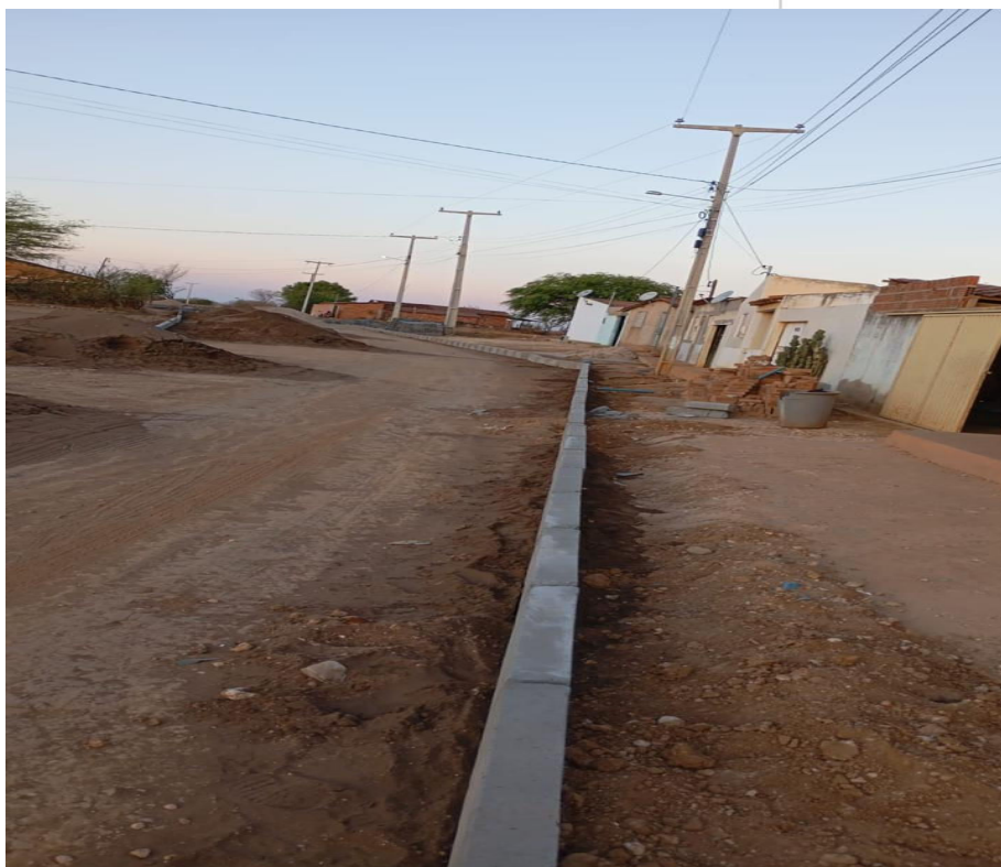
IMAGEM 20: PAVIMENTAÇÃO NO POVOADO DE MUNDINHO, ITAGUAÇU DA BAHIA - BAHIA
