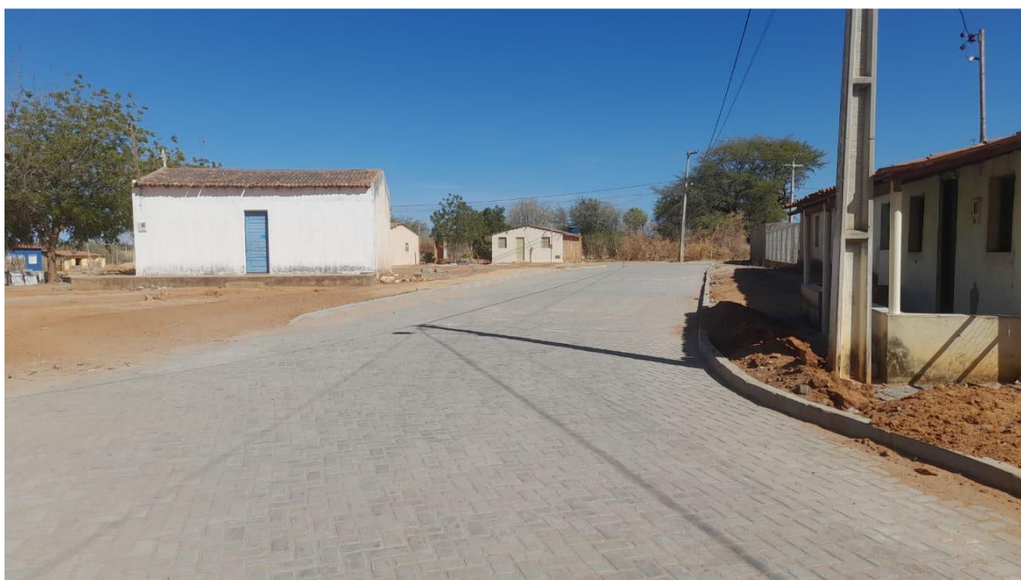
IMAGEM 05: PAVIMENTAÇÃO NO POVOADO DE TABATINGA ITAGUAÇU DA BAHIA - BAHIA
