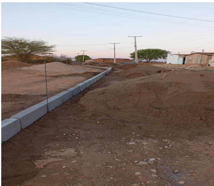
IMAGEM 21: PAVIMENTAÇÃO NO POVOADO DE MUNDINHO, ITAGUAÇU DA BAHIA - BAHIA
