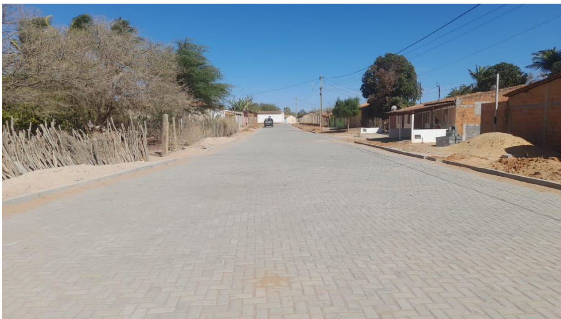
IMAGEM 07: PAVIMENTAÇÃO NO POVOADO DE TABATINGA ITAGUAÇU DA BAHIA - BAHIA
