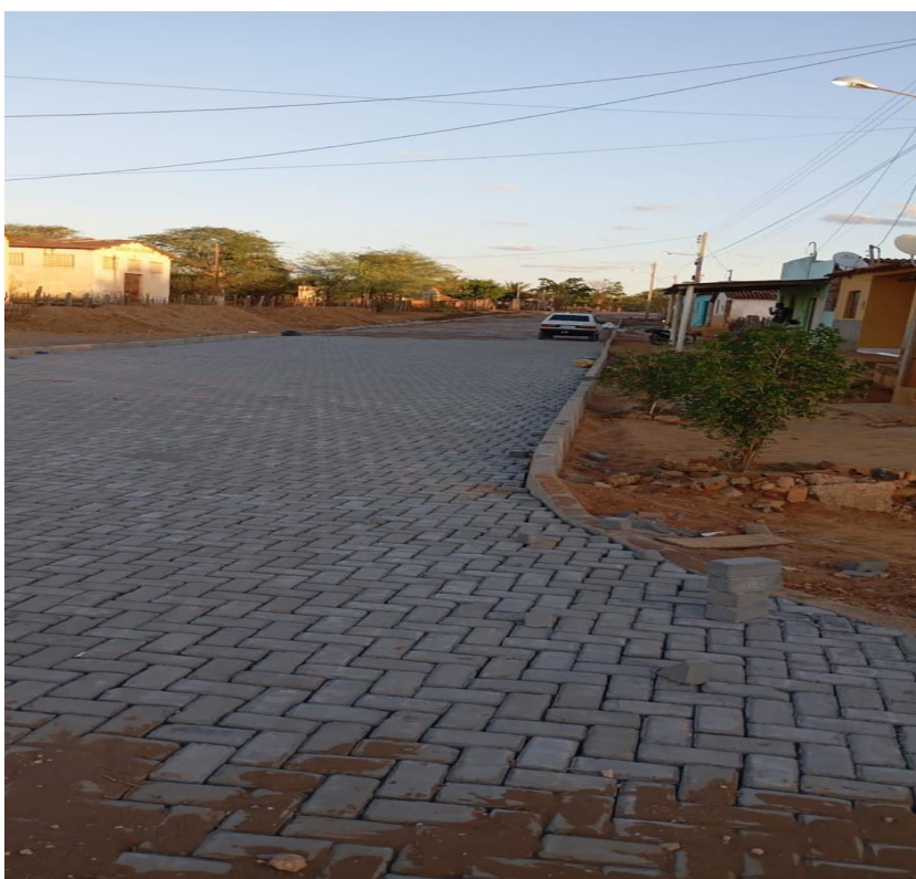
IMAGEM 16: PAVIMENTAÇÃO NO POVOADO DE MUNDINHO, ITAGUAÇU DA BAHIA - BAHIA
