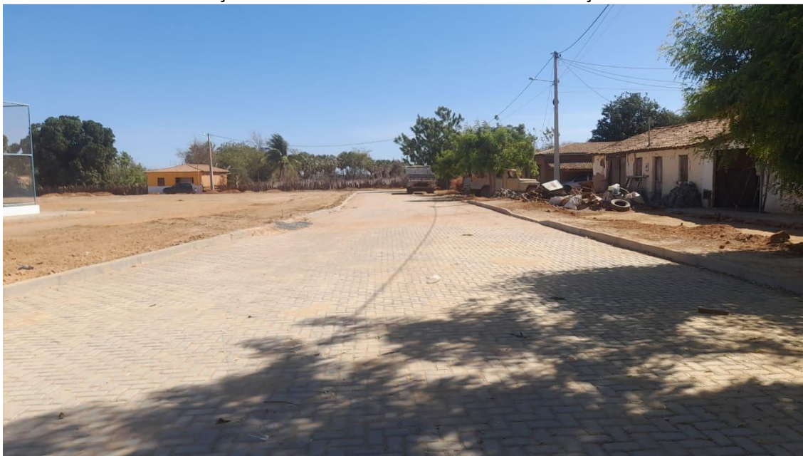
IMAGEM 11: PAVIMENTAÇÃO NO POVOADO DE TABATINGA ITAGUAÇU DA BAHIA - BAHIA
