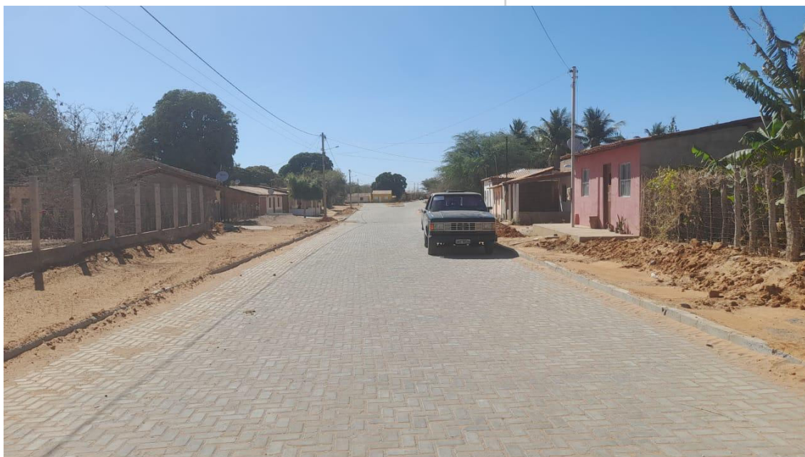
IMAGEM 04: PAVIMENTAÇÃO NO POVOADO DE TABATINGA ITAGUAÇU DA BAHIA - BAHIA
