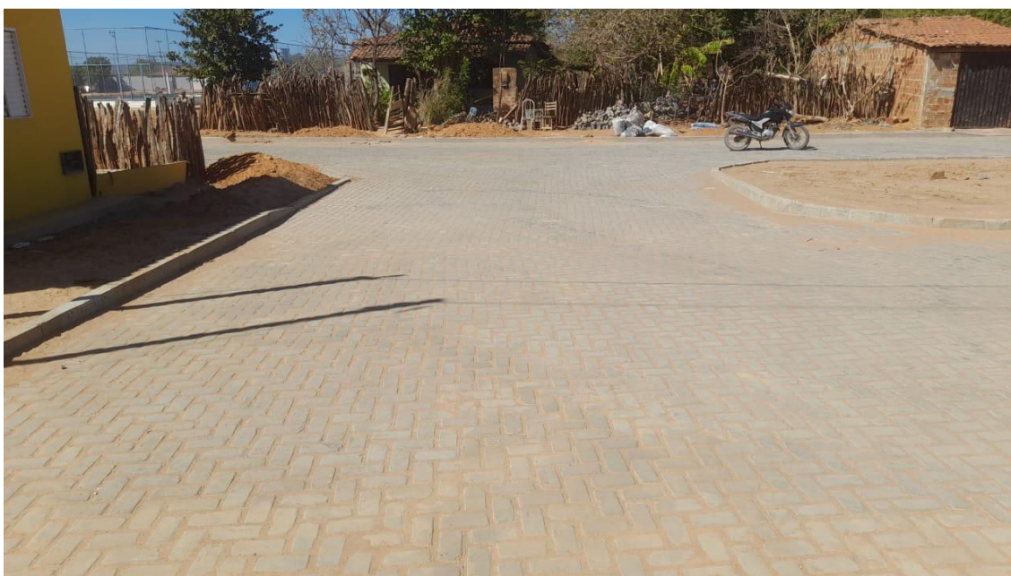
IMAGEM 09: PAVIMENTAÇÃO NO POVOADO DE TABATINGA ITAGUAÇU DA BAHIA - BAHIA
